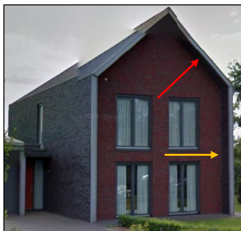
De voorzijde van de woning met dakoverstek en geveluitkraging (bron: Google Street View)
