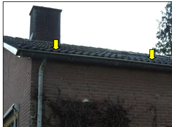
Figuur 9. Ruimtes tussen het dak en de dakgoot bieden potentieel geschikte ruimtes voor de huismus.
