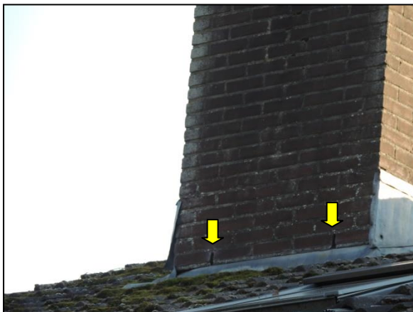
Figuur 10. Stootgaten bieden toegangsmogelijkheden tot de spouwmuur.
