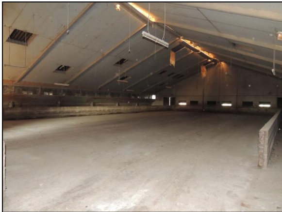
Figuur 12. De draagbalken bieden potentiële wegruijpmogelijkheden en vrije hangplekken voor vleermuizen.
