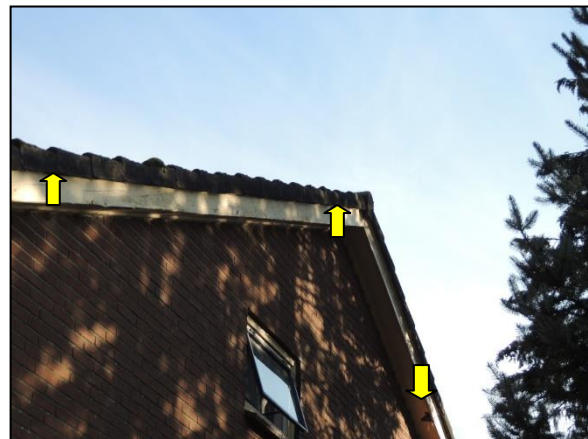
Figuur 11. Ruimtes langs de dakrand en achter betimmering bieden toegangsmogelijkheden tot onder het dak.
