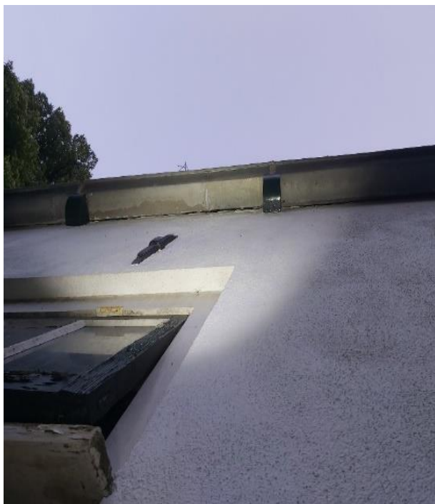
Figuur 7. Tussen de gevel en de dakgoot werden 14 gewone dwergvleermuizen waargenomen. Op de foto zijn tussen de dakgoot en de gevel de vleermuizen te zien.
