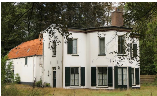
Figuur 8. Het Witte Huis gezien vanaf de Oude Woudenbergsezandweg (Google Streetview).
