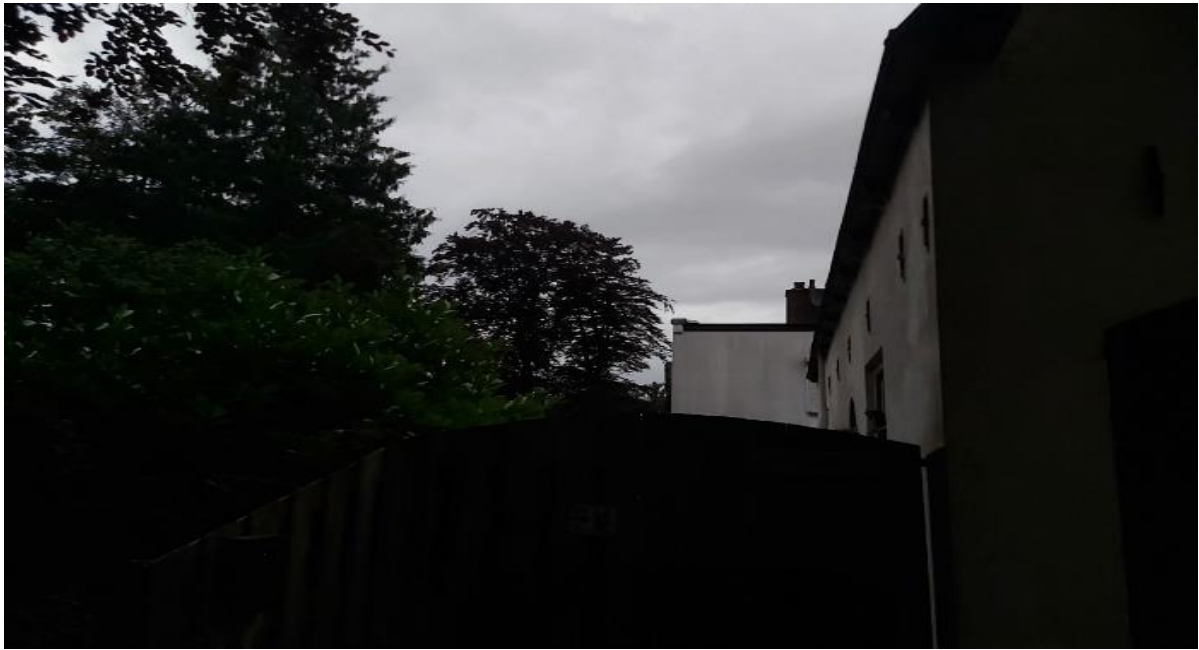
Figuur 6. Via het lood aan de zijkant van de kopgevel aan de achterzijde van het huis werden minstens 32 uitvliegende gewone dwergvleermuizen geteld. De ruimte die hier aanwezig is leidt naar een afgesloten zolder.
