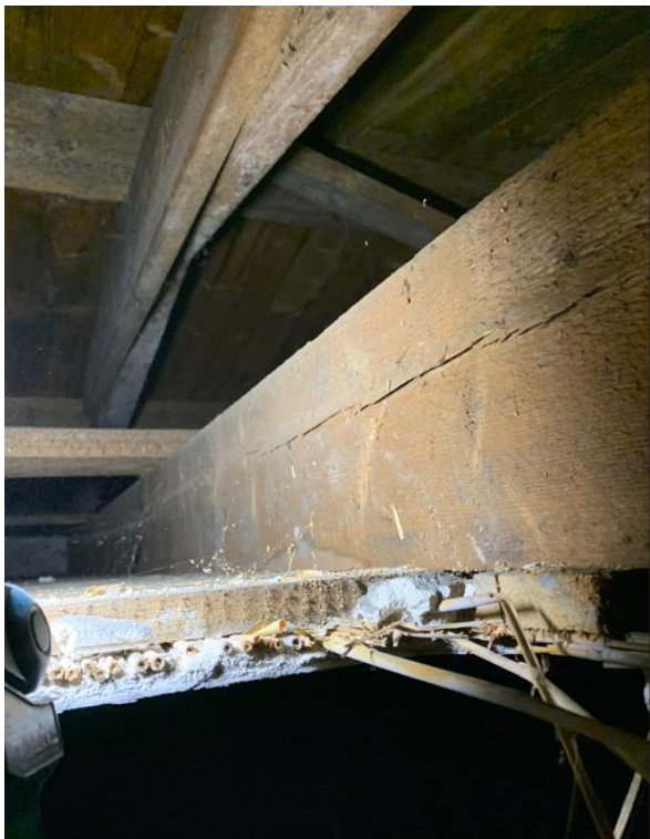
Figuur 16; Aan de onderkant van de foto is het rieten plafond met gipsplaat te zien, wat aan de onderzijde geïsoleerd zal worden.
