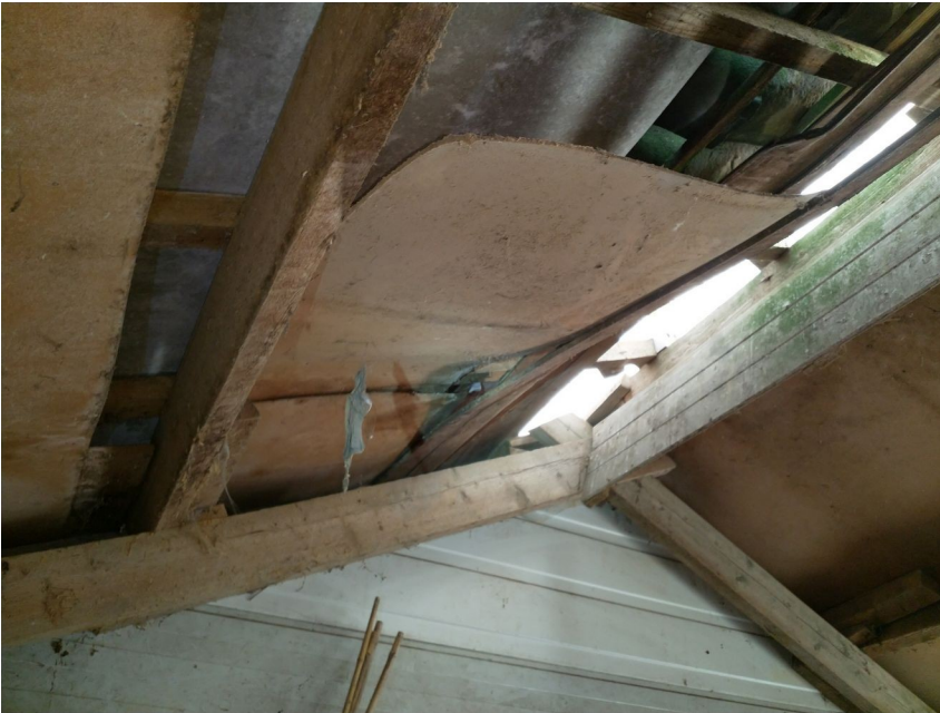
Afbeelding 12: Tussen de daklagen kunnen de huismussen broeden. Foto: M.S. de Haan | Ecoresult B.V.
