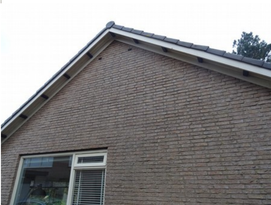
zijgevel Griftdijk 3a met bovenin de dichte spouwgaten
