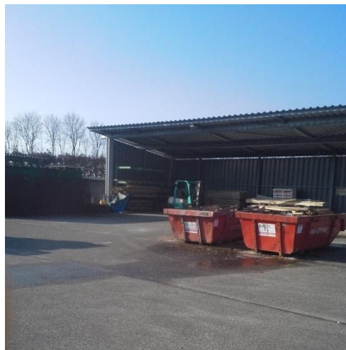
foto 2: zuidwestelijk terreindeel (overkapping)
