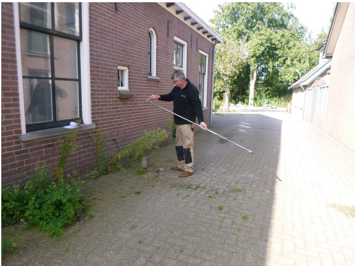
Figuur 6: Woudenberg, Zegheweg 8a. Booronderzoek ter plaatse van boorpunt 2.
