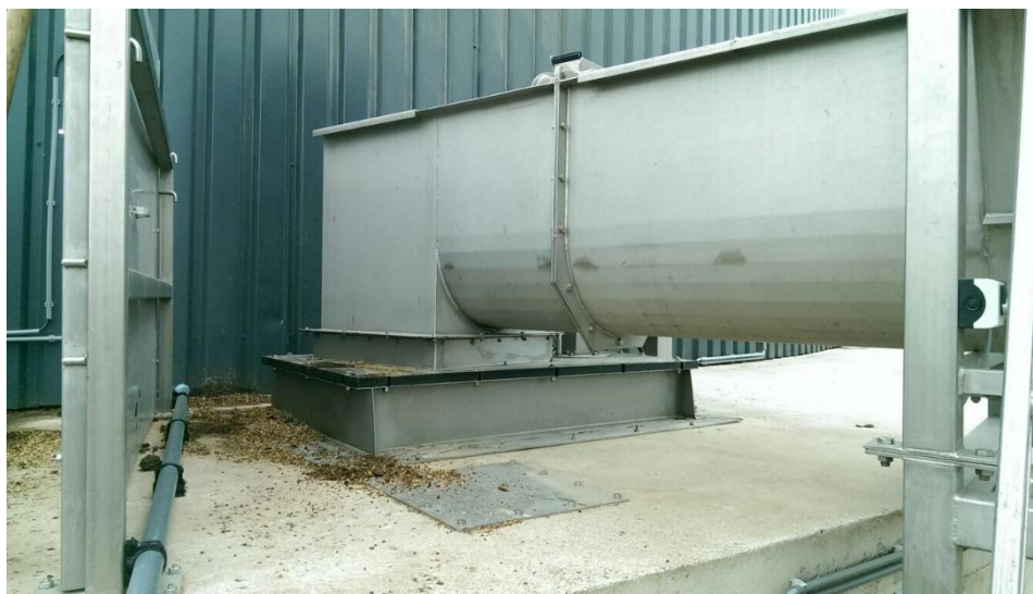
Figuur 2: impressie van het nieuwe schroefvijzel invoersysteem in de hydrolyse-/mengring
