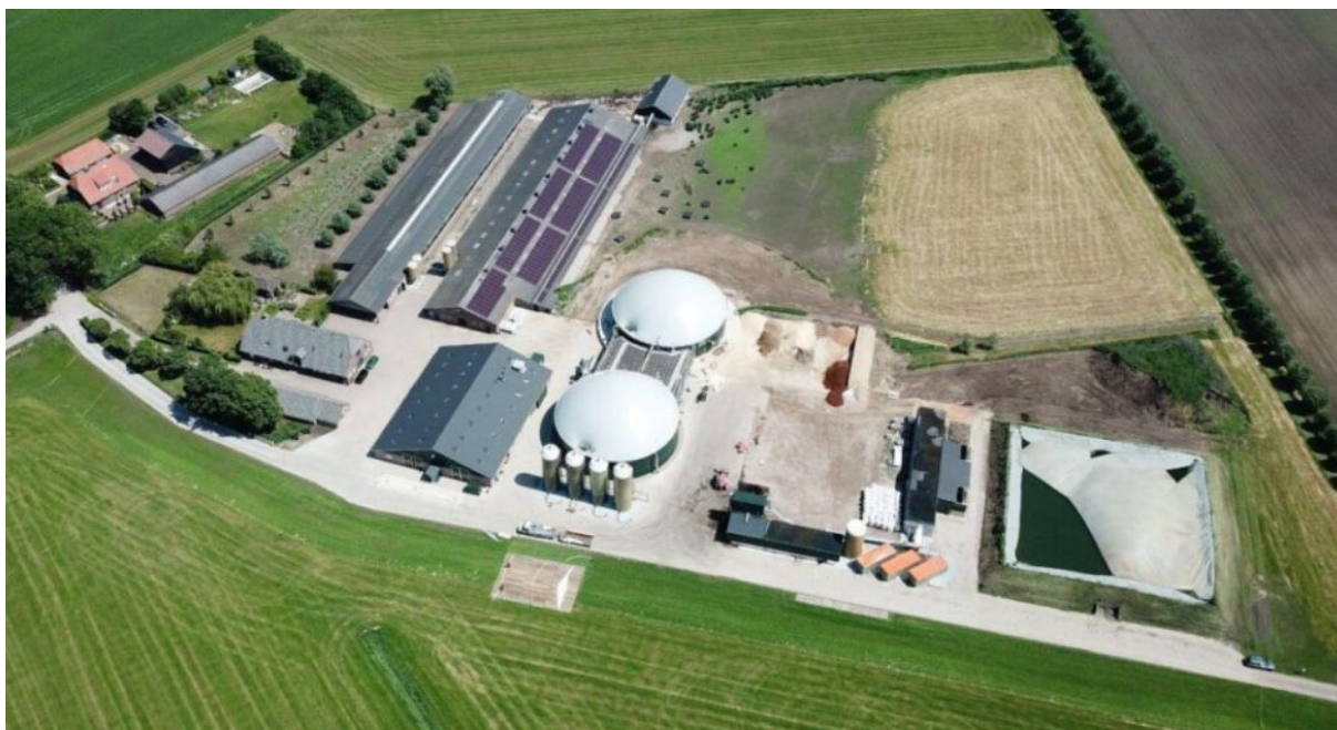
Foto impressie van de huidige gebouwen en installatie onderdelen
