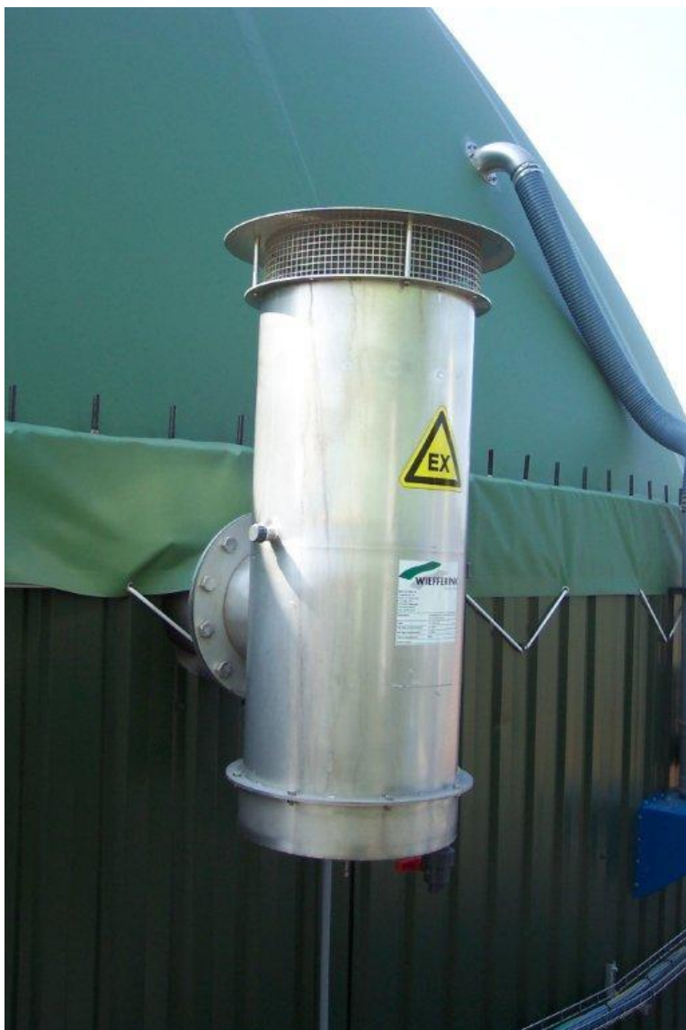
Foto: de mechanische overdruk- en onderdrukbeveiliging
