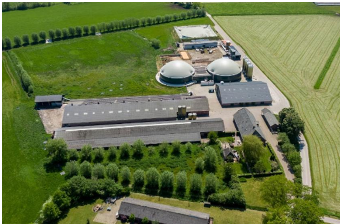
Foto impressie van de huidige gebouwen en installatie onderdelen
