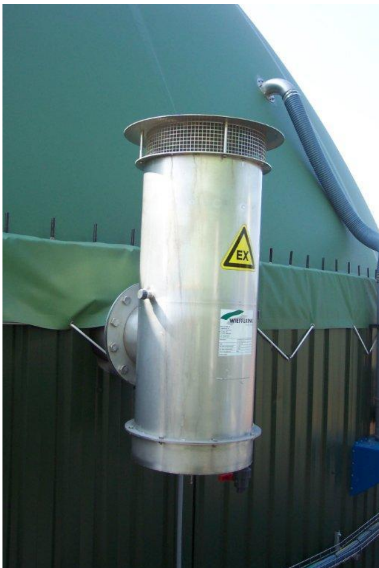
Foto: de mechanische overdruk- en onderdrukbeveiliging
