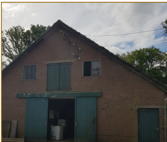
Afb. 2.3: Noordzijde van schuur 2.
