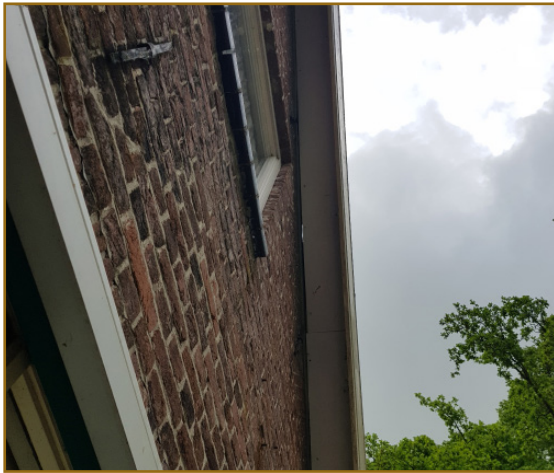
Afb. 2.7: Foto van het overstek van de woning waarbij niet genoeg ruimte is voor vleermuizen.
