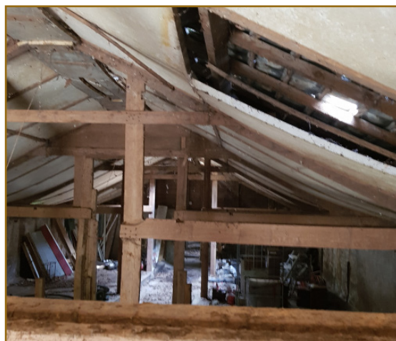
Afb. 2.14: De binnenkant van schuur 3.
