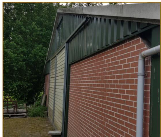
Afb. 2.10: Foto van schuur 5 met de metalen wandbeplating.
