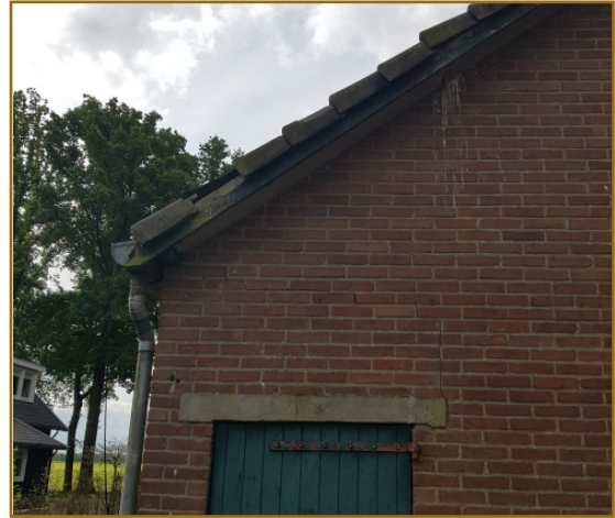
Afb. 2.2: Noordzijde van schuur 2.
