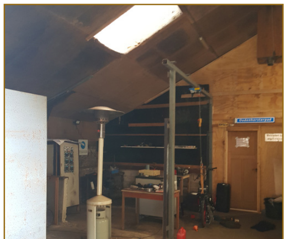
Afb. 2.12: De binnenkant van schuur 4.
