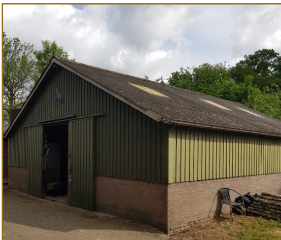
Afb. 2.9: Overzichtsfoto van schuur 4 met de metalen wandbeplating.
