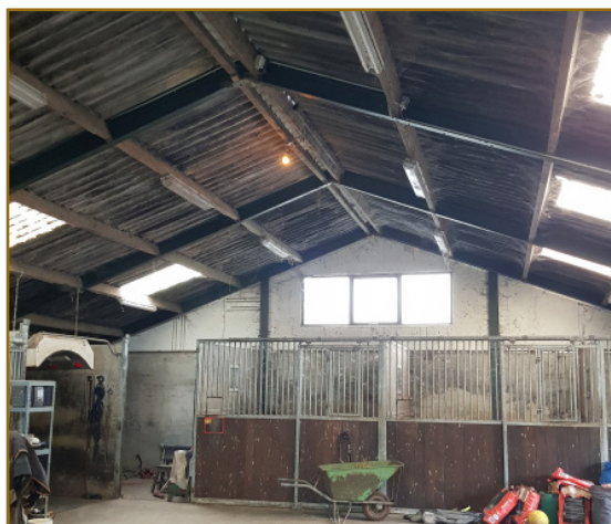
Afb. 2.13: De binnenkant van schuur 5.
