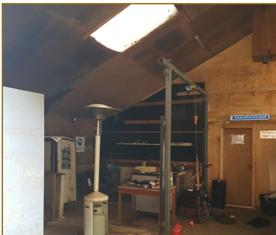
Afb. 2.15: De binnenkant van schuur 4.
