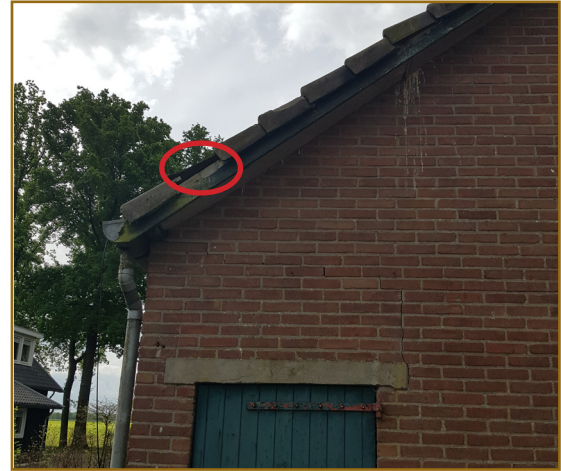
Afb. 2.2: Plaats van een spreeuwennest (rode cirkel) aan de noordzijde van schuur 2.
