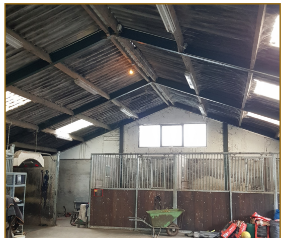
Afb. 2.16: De binnenkant van schuur 5.
