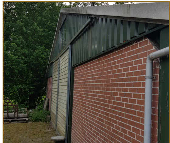
Afb. 2.10: Foto van schuur 5 met de metalen wandbeplating.
