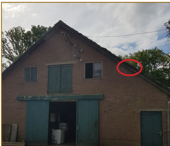
Afb. 2.3: Plaats van een spreeuwennest (rode cirkel) aan de noordzijde van schuur 2.
