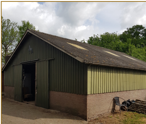
Afb. 2.9: Overzichtsfoto van schuur 4 met de metalen wandbeplating.
