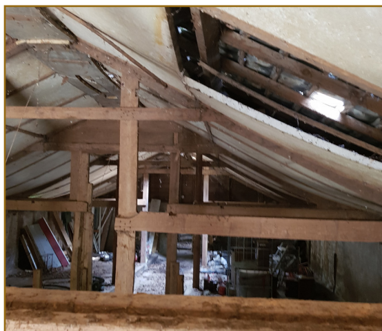
Afb. 2.17: De binnenkant van schuur 3.
