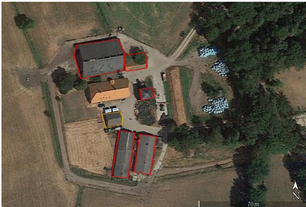
Luchtfoto van het erf van Moorsterweg 3 met de te slopen stallen, kapschuur en hooimijt (rood omlijnd) en de mogelijk te slopen stal (geel omlijnd)
