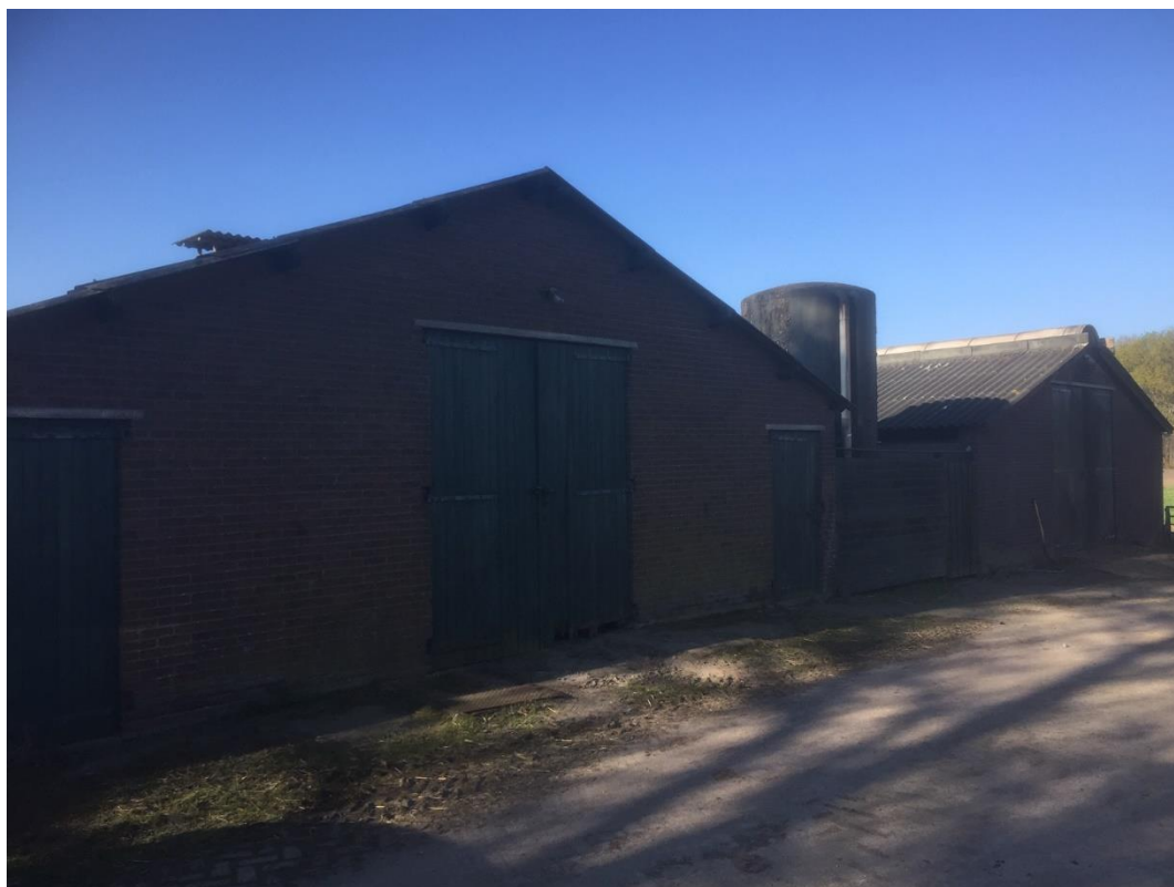
Figuur 3. Twee van de te slopen stallen.
