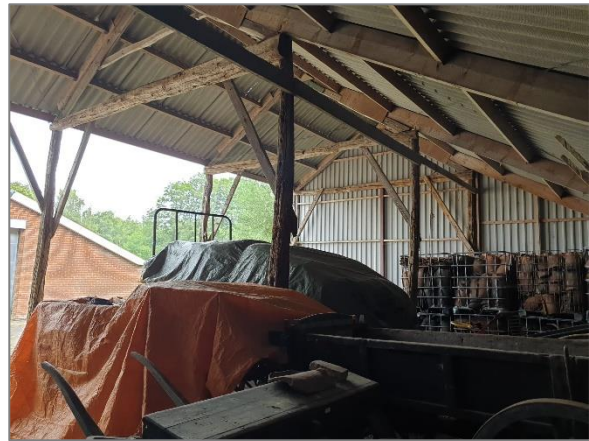
Afbeelding 1.8 | Open schuur 3 aan binnenzijde
