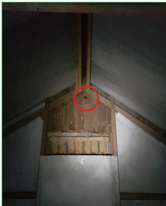
Afbeelding 3.4: Tussen het hout aan de achterzijde van de lange schuur en de golfplaten aan de buitenkant bevinden zich verblijfplaatsen van de grootoorvleermuis.
