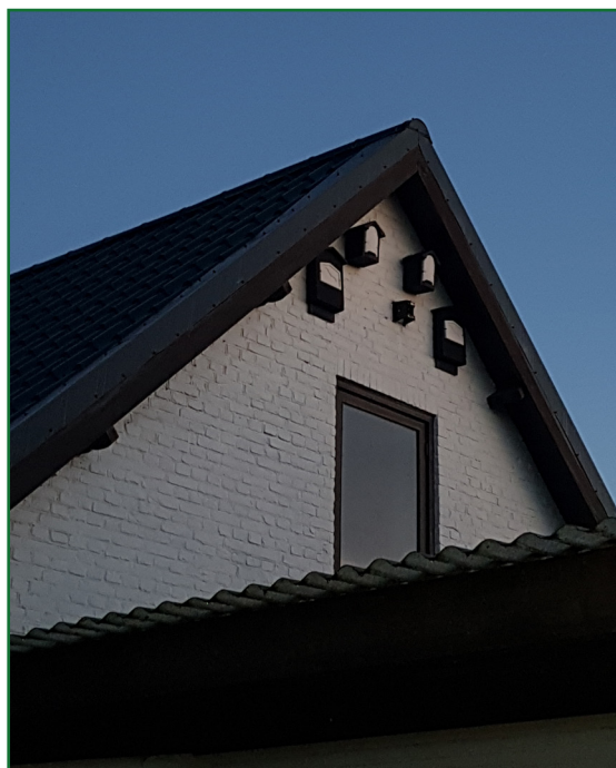
Afbeelding 3.9: Aan de oost- en westgevels van de woning zijn in totaal 8 vleermuiskasten opgehangen. De woning is het enige bouwwerk dat behouden blijft totdat de nieuwbouw gerealiseerd is.
