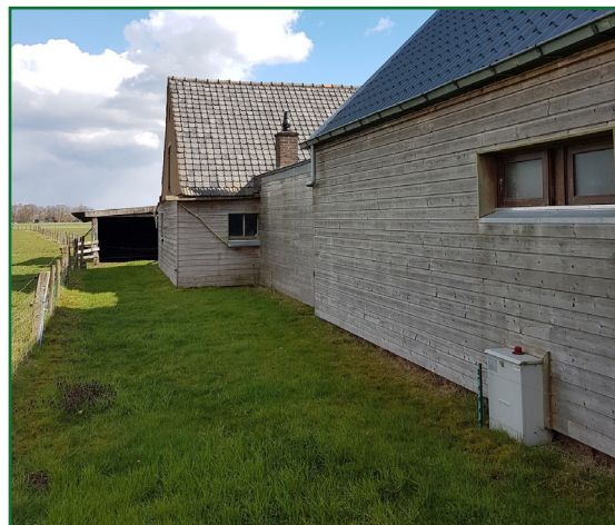
Afb. 2.4: Achterzijde van het huis aan de noordkant. De begroeiing bestaat enkel uit gazon. Aan deze zijde zijn geen openingen voor vleermuizen of vogels om in tussenruimtes te komen.
