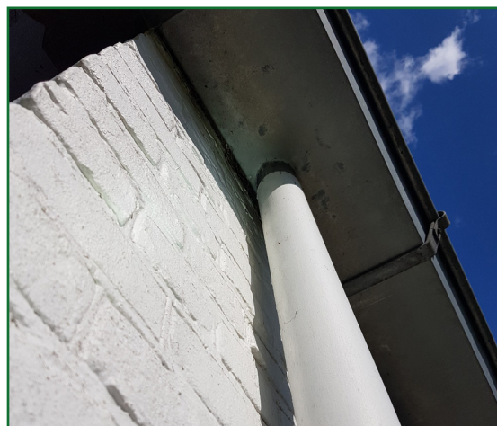
Afb. 2.2: Tussen de muur en dakrand aan de zuidkant van de woning zijn spleten aanwezig dat voor vleermuizen als ingang kan dienen om in de spouwmuur te verblijven.
