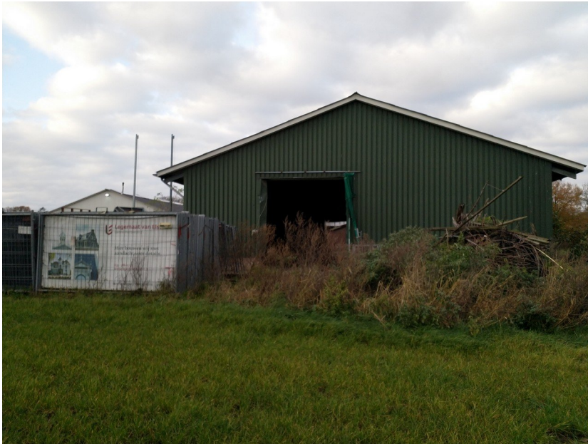
Afbeelding 4: De groene hoge schuur betreft de oostelijke schuur welke gesloopt wordt. De schuur wordt nu gebruikt als opslag. Foto: M.S. de Haan / Ecoresult B.V.
