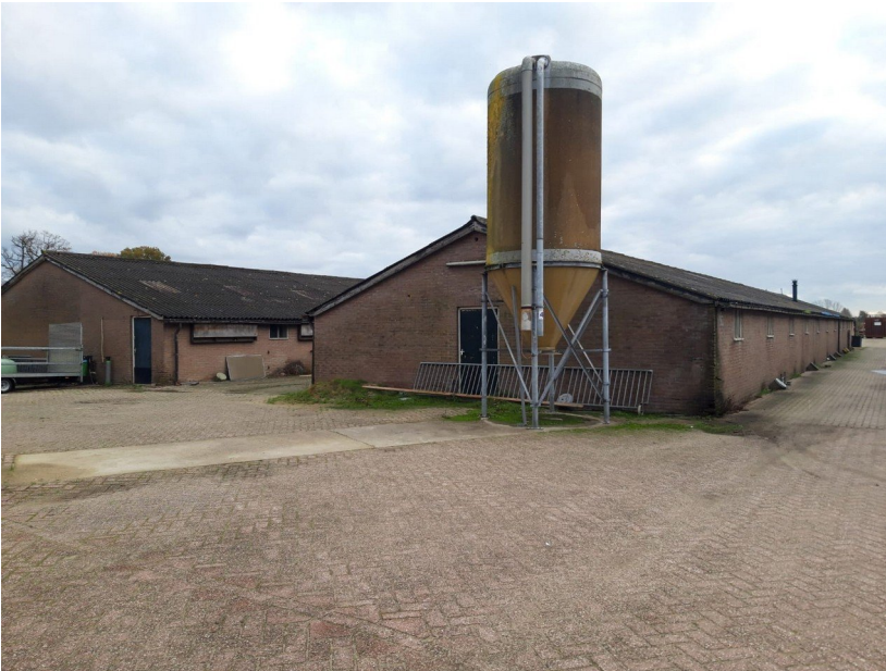
Afbeelding 3: De twee oude varkensstallen. Foto gemaakt vanuit het zuidwesten, kijkend naar het noordoosten. Foto: M.S. de Haan / Ecoresult B.V.
