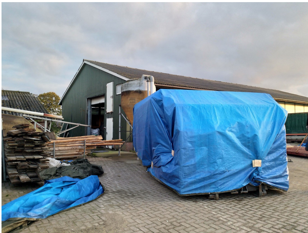
Opslag van materiaal rondom het plangebied. De bebouwing achterin betreft de hoge schuur welke gesloopt gaat worden. Foto: M.S. de Haan | Ecoresult B.V.
