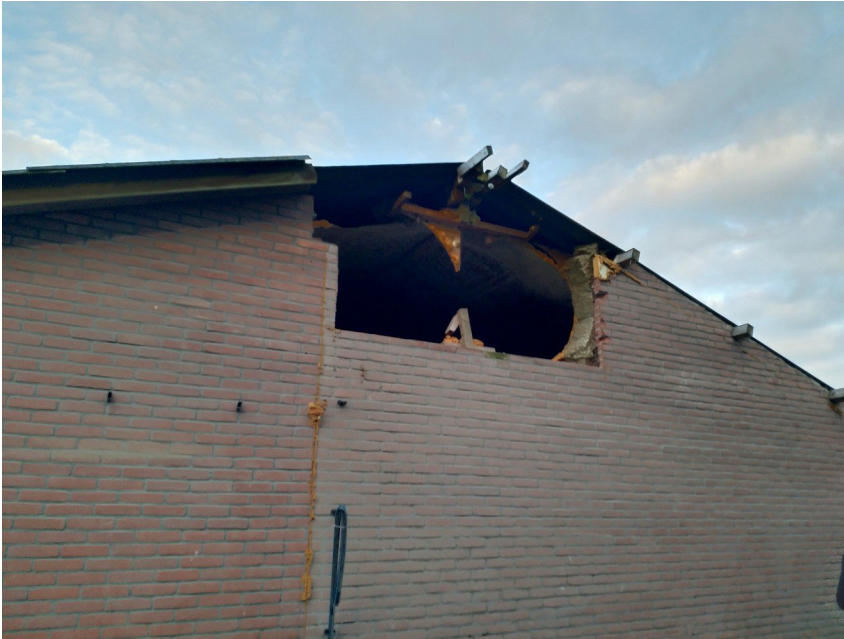
Afbeelding 13: Het gat in de noordelijke varkensstal aan de oostelijke kopgevel welke toegang geeft voor vleermuizen. Binnen de bebouwing zijn tussen de golfplaten en kunststoffen platen geschikte ruimtes aanwezig voor vleermuizen. Foto: M.S. de Haan | Ecoresult B.V.
