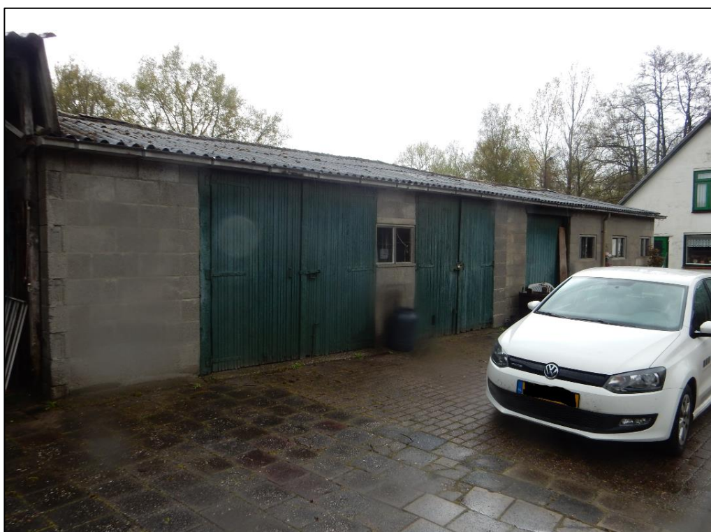
Figuur 8 Gebouw 8 (voor) en 9 (achter) zullen gesaneerd worden.
