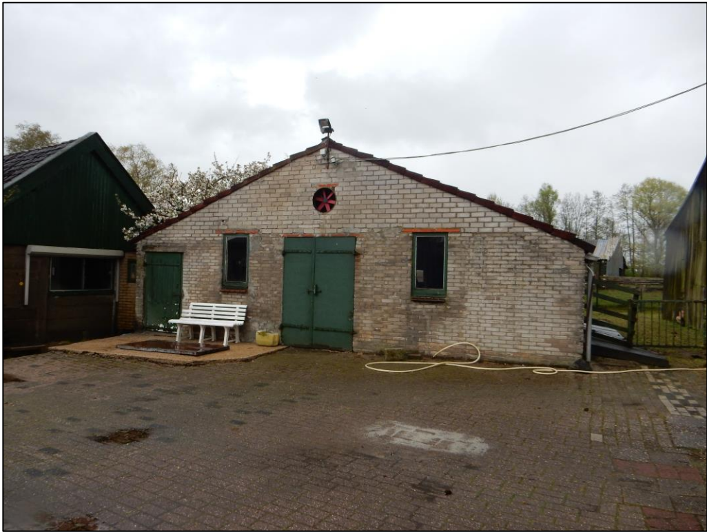
Figuur 3 Gebouw 3 zal gesaneerd worden.
