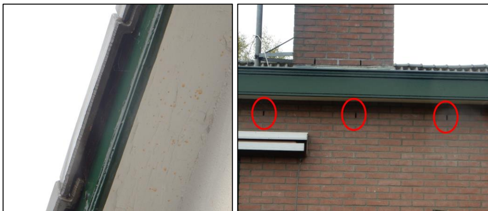
Figuur 4 Visuele representatie van potentiële invliegopeningen voor vleermuizen. Links: kierende kantpannen. Rechts: open stootvoegen.
