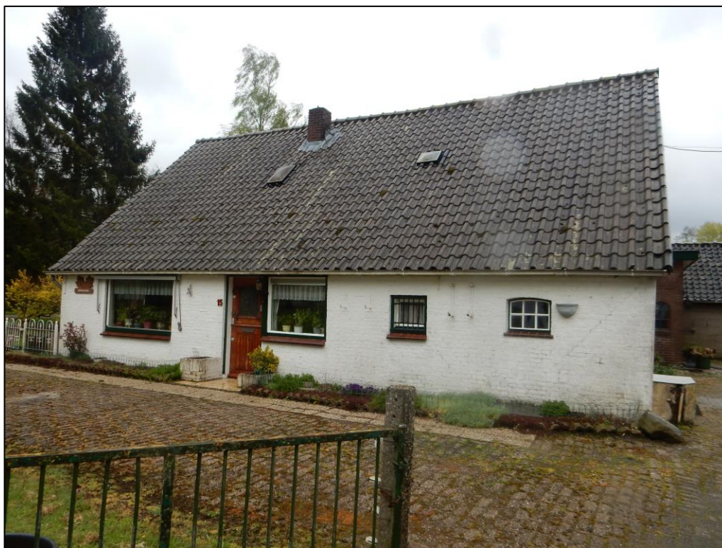
Figuur 1 Gebouw 1 zal gesaneerd worden.
