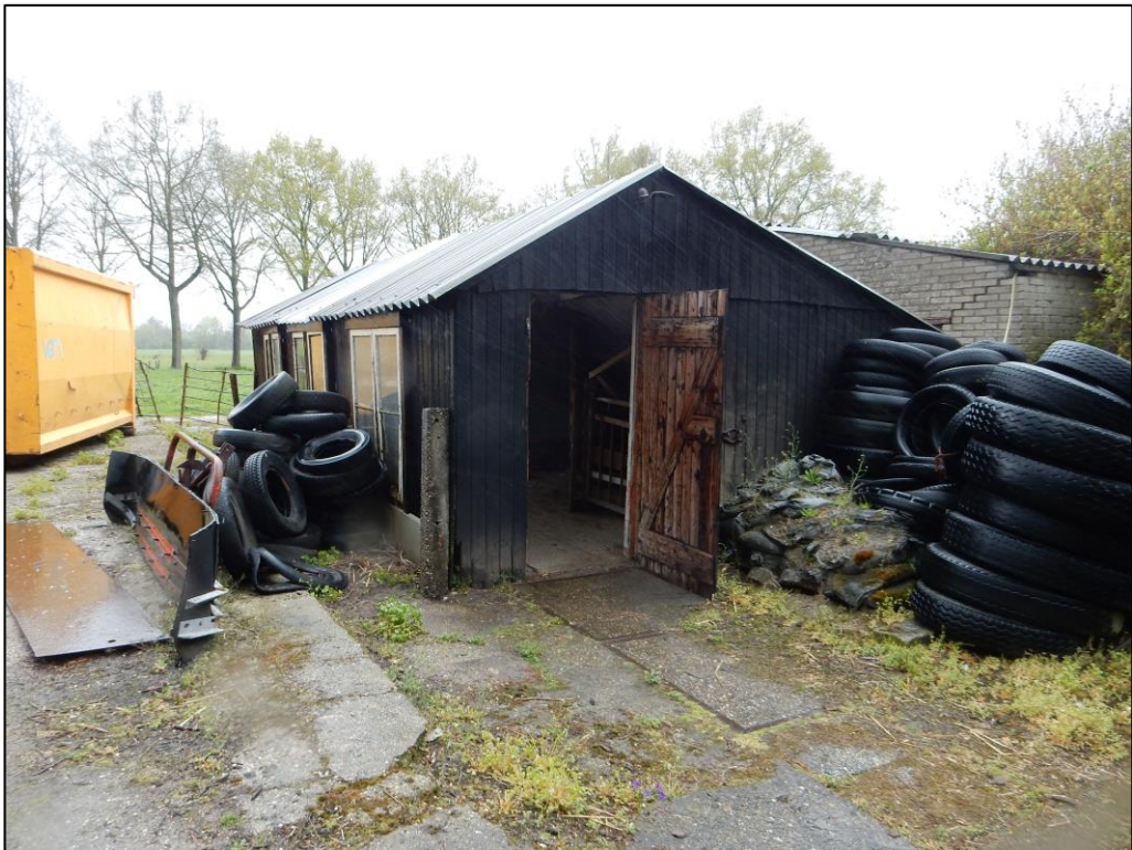
Figuur 6 Gebouw 6 zal gesaneerd worden.
