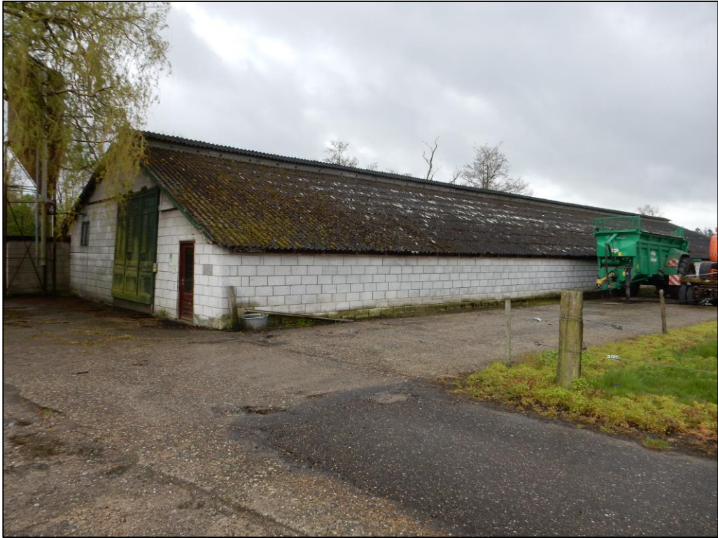
Figuur 5 Gebouw 5 zal gesaneerd worden.
