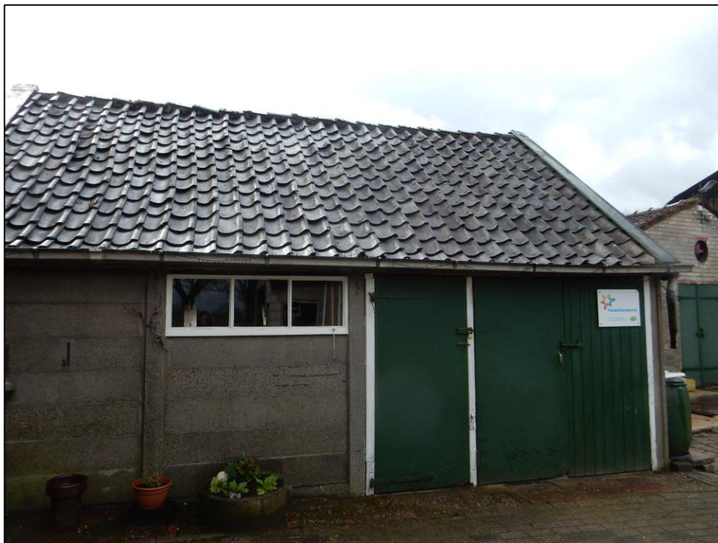
Figuur 2 Gebouw 2 zal gesaneerd worden.
