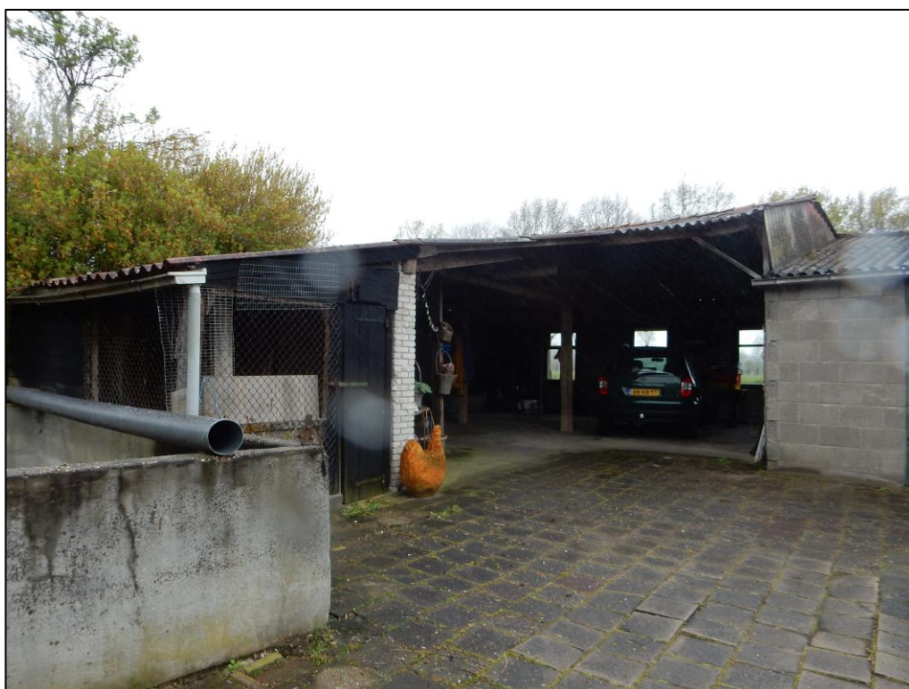
Figuur 7 Gebouw 7 zal gesaneerd worden.
