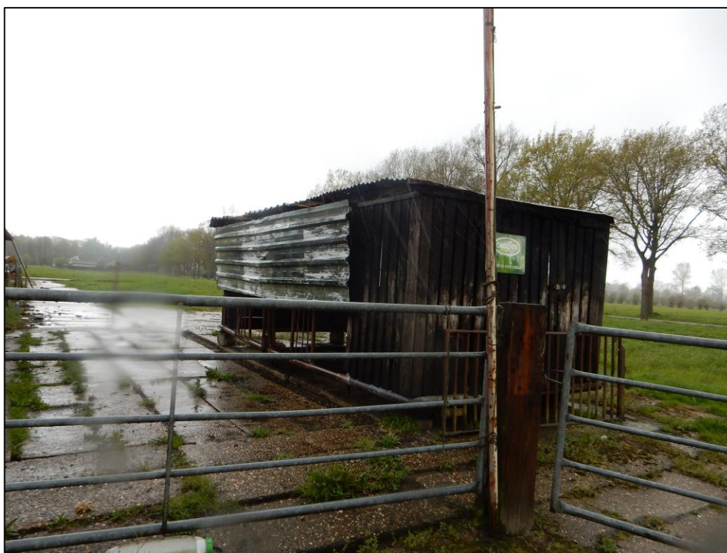
Figuur 9 Gebouw 10 zal gesaneerd worden.
