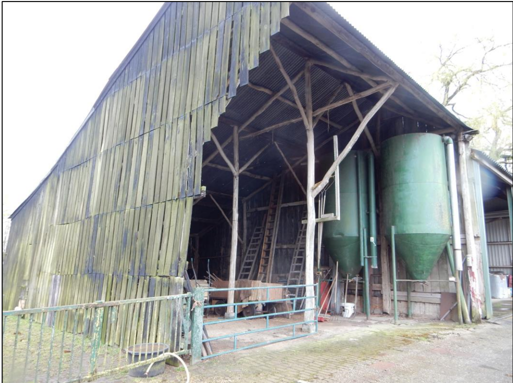
Figuur 4 Gebouw 4 zal gesaneerd worden.
