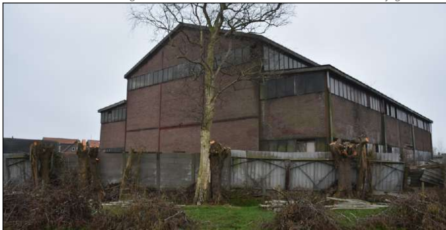
Figuur: ten zuidoosten van het plangebied staan vervallen gebouwen met veel openingen, bijvoorbeeld door het ontbreken van ramen. Hierin kunnen vleermuizen, steenuil en kerkuil verblijfplaatsen hebben.
