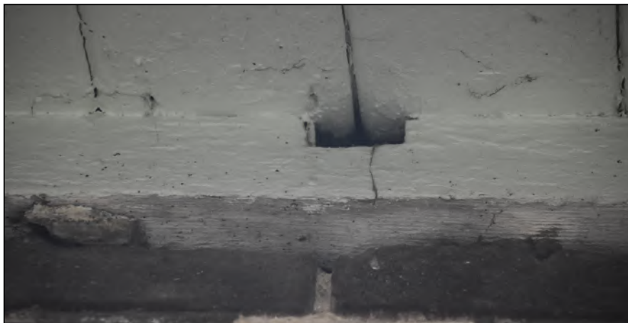
Figuur: het woonhuis heeft op verscheidene plaatsen openingen onder de dakrand. Hier kunnen vleermuizen in kruipen. Deze mogelijke verblijfplaatsen zullen niet vernietigd worden, er kunnen echter wel negatieve effecten optreden door trillingen en lichteffecten.
