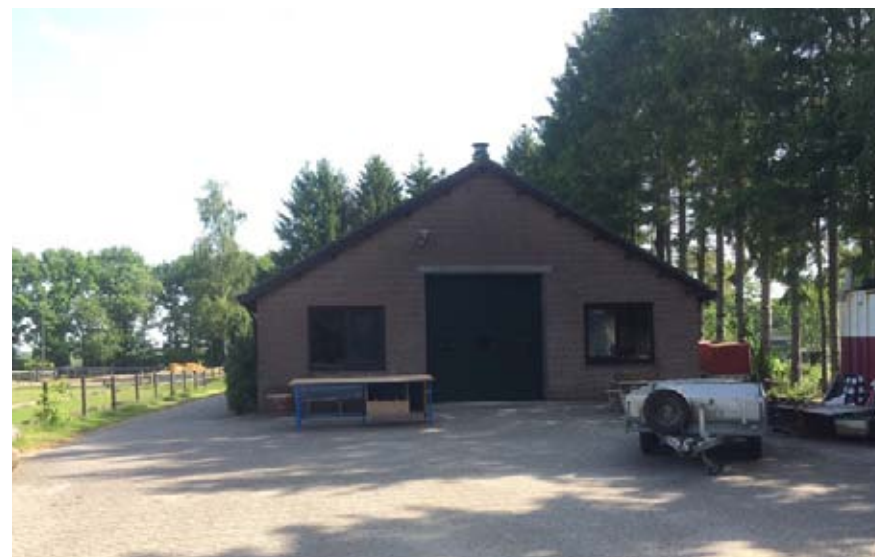
De achterzijde van het bedrijfspand met een grote roldeur.
