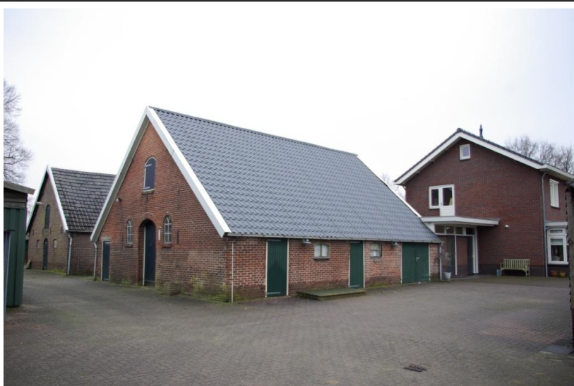
Foto-5 Te restaureren bijgebouw, blijft bestaand
