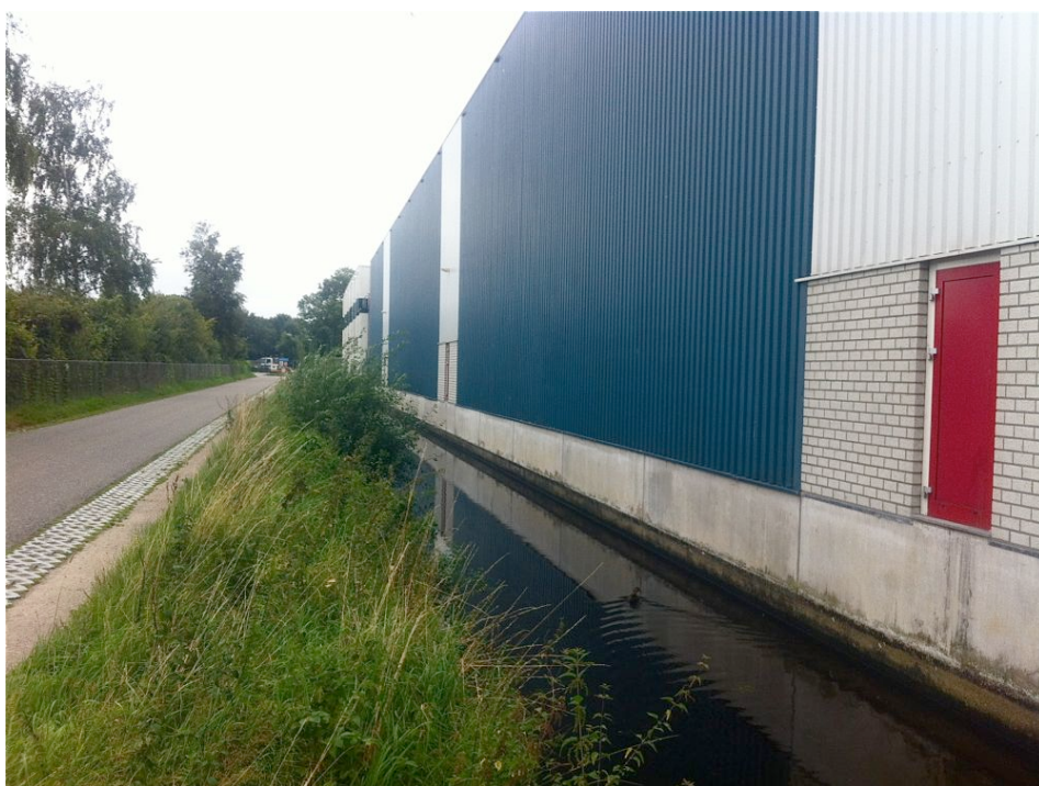
Foto 2 Afwateringsloot langs De Nort, noordkant.
