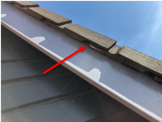
Potentiele verblijfplaats werkschuur
