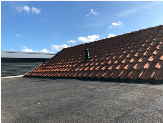
Overgang dakpannen/plat dak winkelpand
