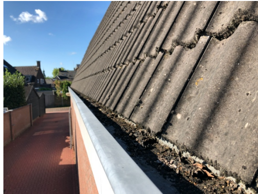
Dakgoot werkschuur volledig afgewerkt
