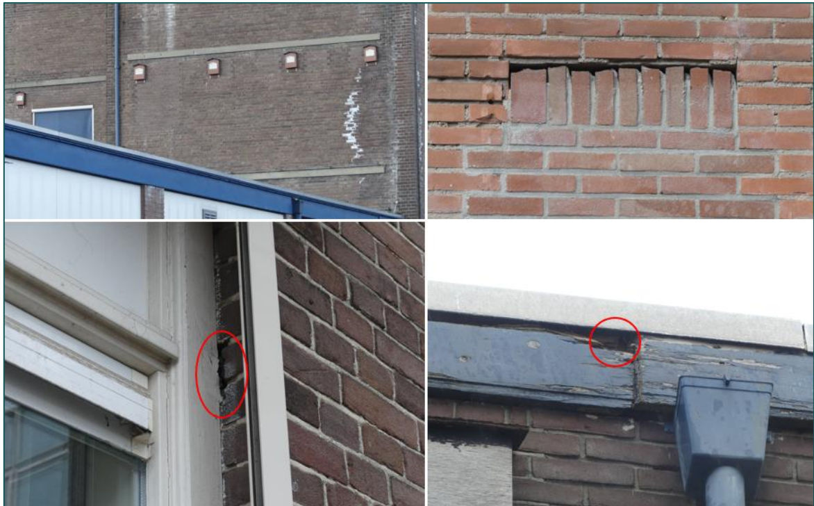
Figuur 3.1 Vleermuizen verblijfplaatsvinden in vleermuiskasten, openingen in het metselwerk, bij kozijnen en in het boeiboord.
