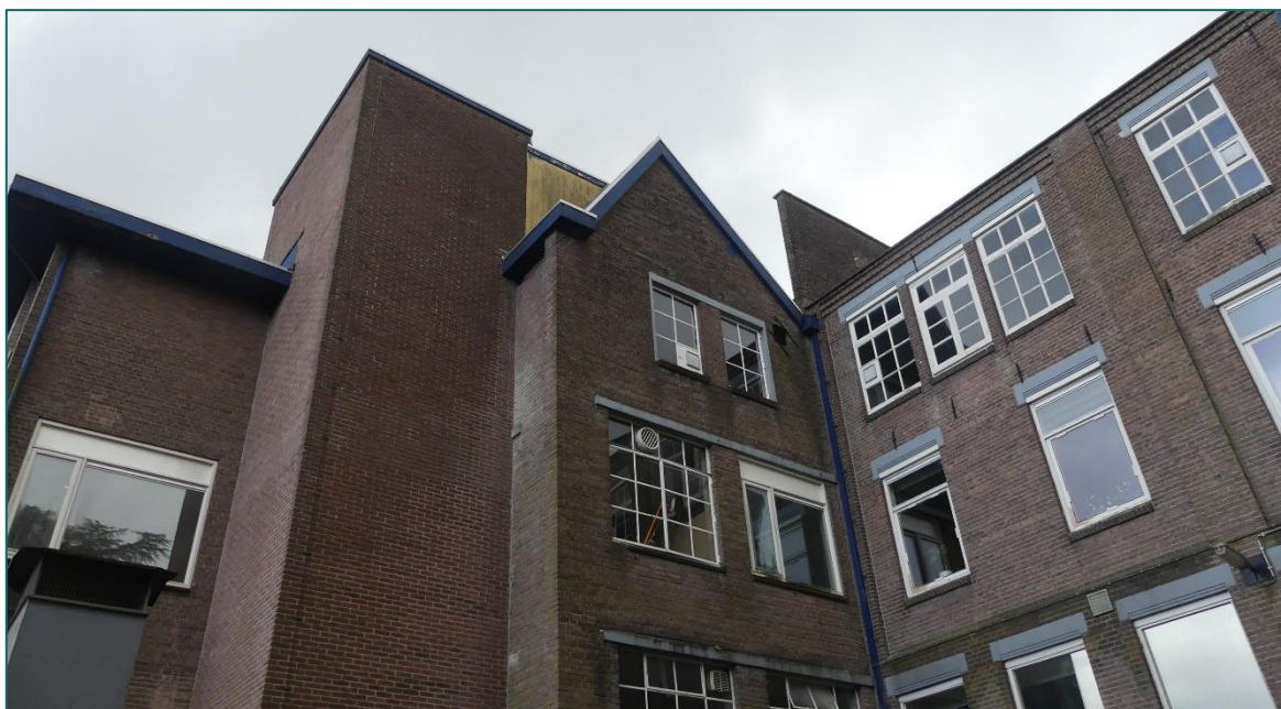
Figuur 1.3 Op de planlocatie is men voornemens om een deel van de bebouwing te slopen en een deel van de bebouwing te restaureren ten behoeve van gebiedsontwikkeling. Hier weergegeven is de te renoveren Kerverij en Pakhuis. Op de linkerhelft staat de te slopen liftschacht weergegeven.
