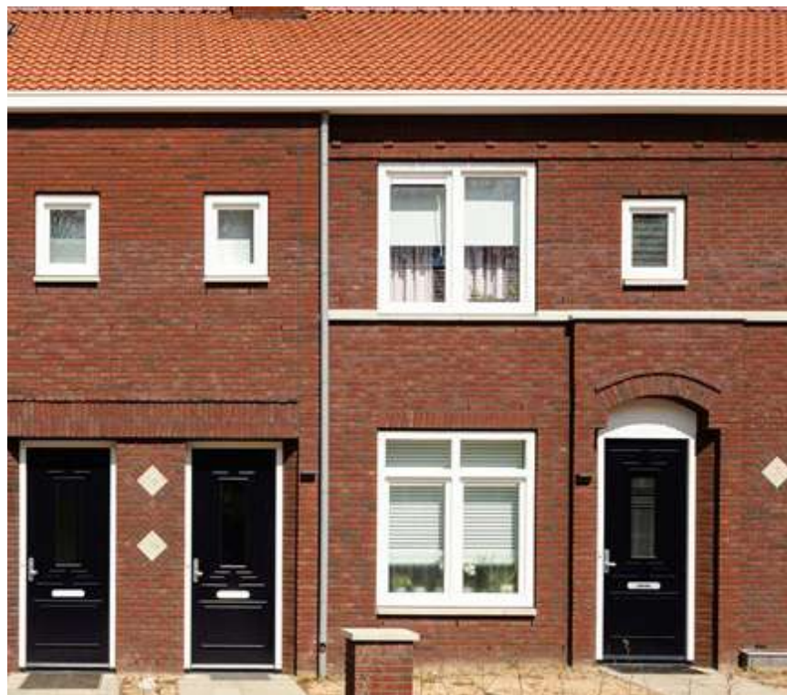
bijzonder metselwerk ter plaatse van de entree
