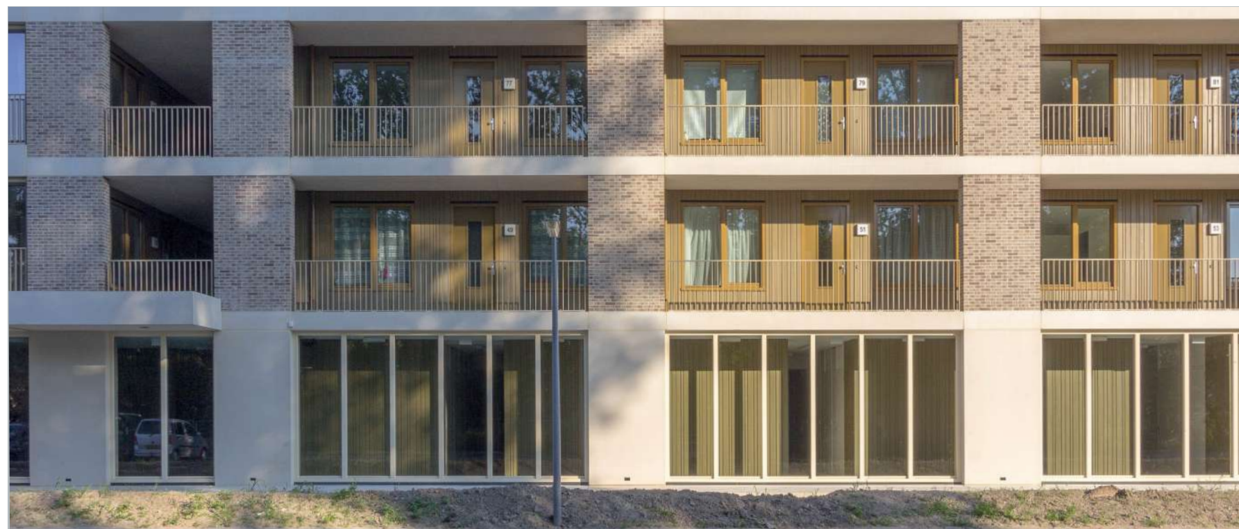
bergingen op de begane grond met galerij hierboven - geen gesloten gevel
