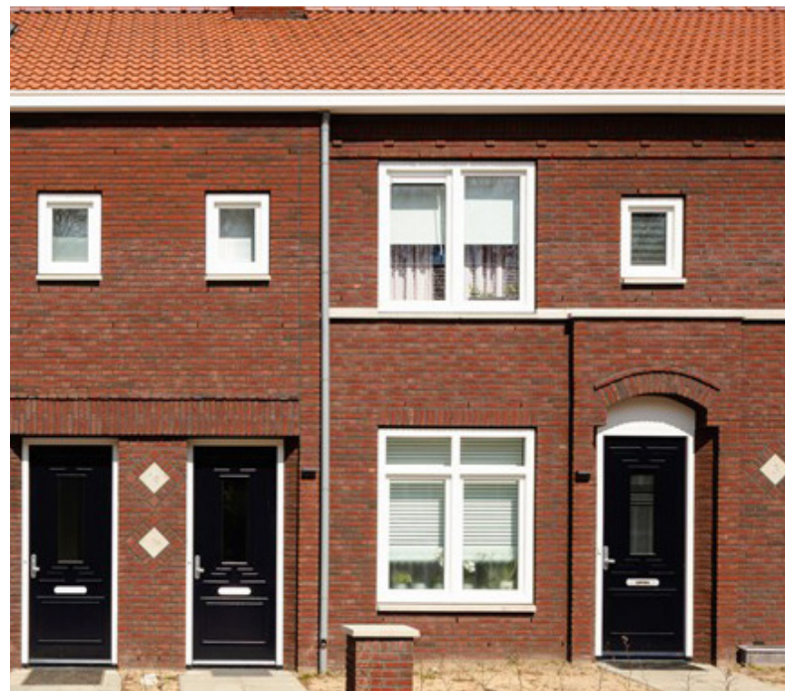
bijzonder metselwerk ter plaatse van de entree
