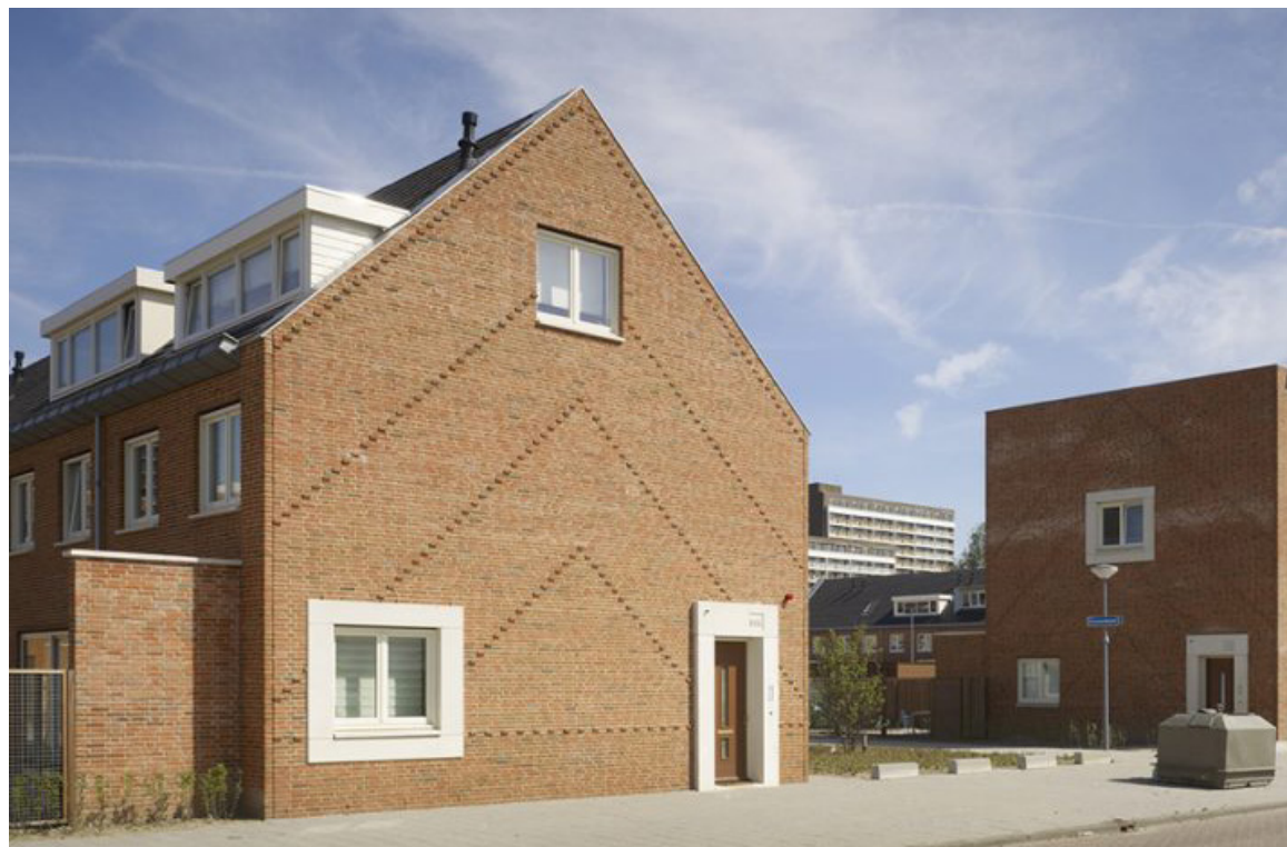
kopgevels met bijzonder metselwerk en entree van de woning
