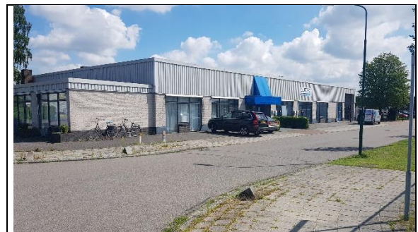
Foto 06 – Laan der Techniek 17
