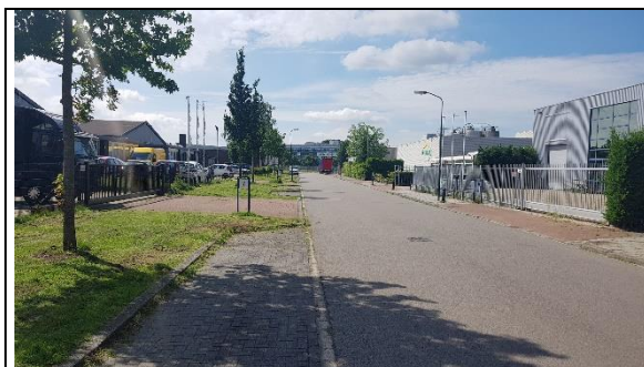
Foto 09 – Laan der Techniek
