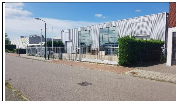
Foto 08 – Laan der Techniek 6
