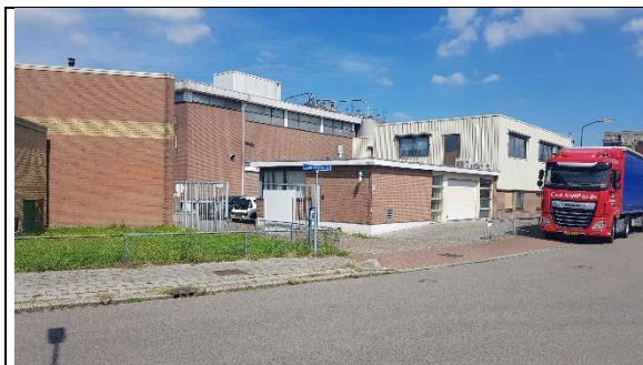
Foto 05 – Laan der Techniek 10/12
