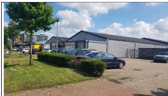
Foto 07 – Laan der Techniek 7 - 15
