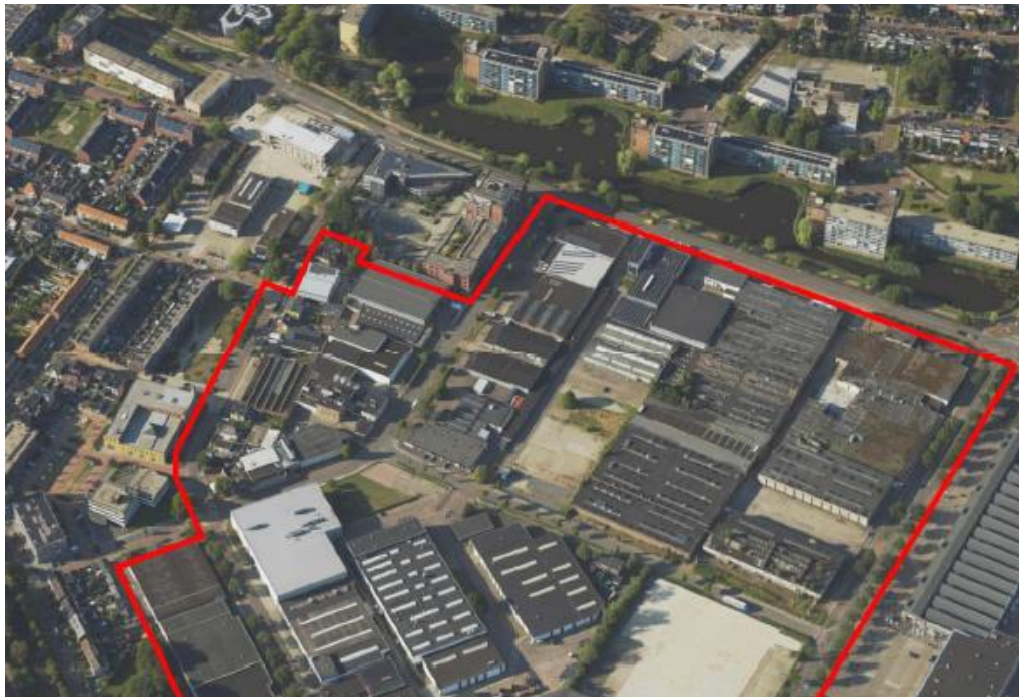
Figuur 7 Luchtfoto huidige situatie noordelijk deel projectgebied (Bron: Google)
