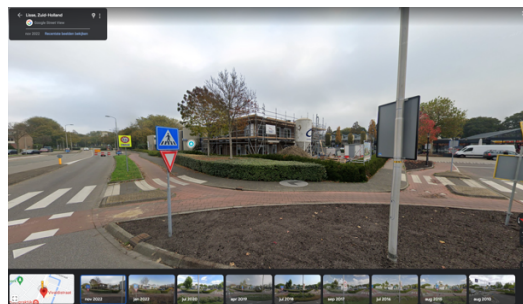
in uitvoering aan de vivaldistraat 2 te Lisse
