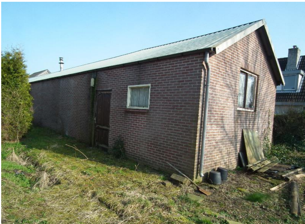
Figuur 2 De schuur is opgetrokken uit gemetselde muren en een dak bestaande uit damwandplaten.
