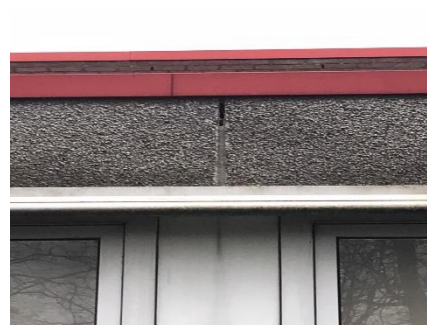
Foto 11: Impressie plangebied (ontbrekend voegwerk, geen invliegmogelijkheid vleermuis).
