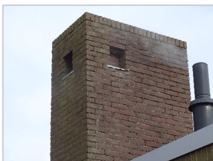
Foto 36: Schoorsteen met openingen bij loodstrips.
