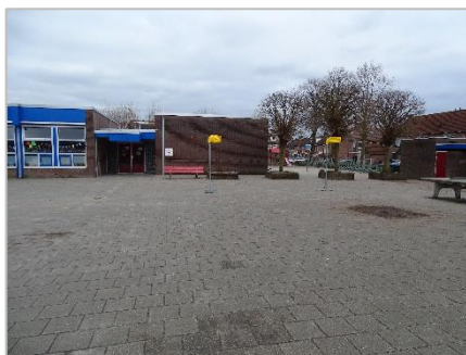
Foto 2: Impressie plangebied (schoolgebouw en schoolplein).
