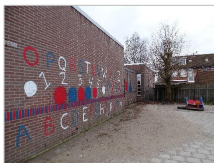
Foto 9: Impressie plangebied (schoolgebouw en schoolplein).
