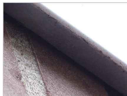
Foto 23: Afgesloten dakranden schoolgebouw.
