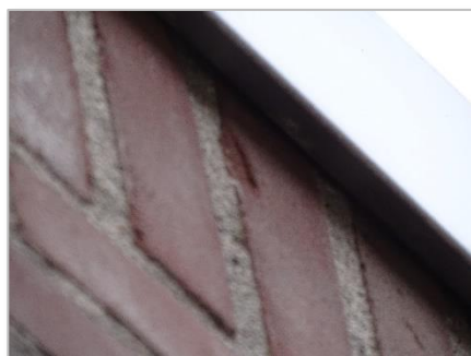
Foto 22: Afgesloten dakranden schoolgebouw.
