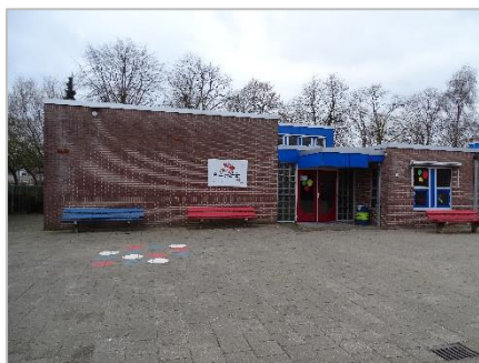
Foto 1: Impressie plangebied (schoolgebouw en schoolplein).
