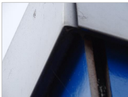
Foto 25: Afgesloten dakranden schoolgebouw.
