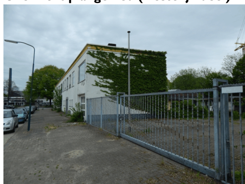
Overzicht plangebied (westelijk deel)
