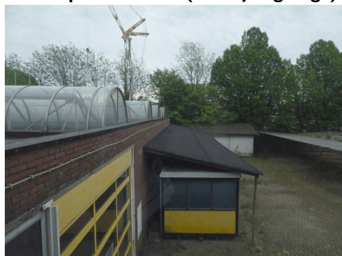
Overkapte barakken (zuidzijde garage)
