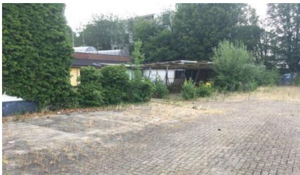
Foto 3: Onbebouwd achterterrein (uitgezonderd open overkapping van staal en polyesterdakplaten)
