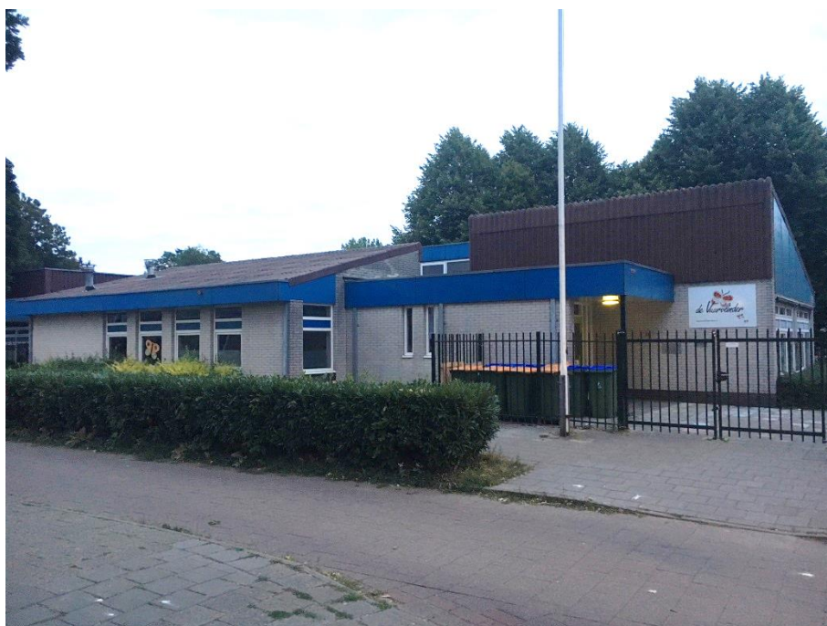
Figuur 10: schoolgebouw ten zuiden van fietspad
