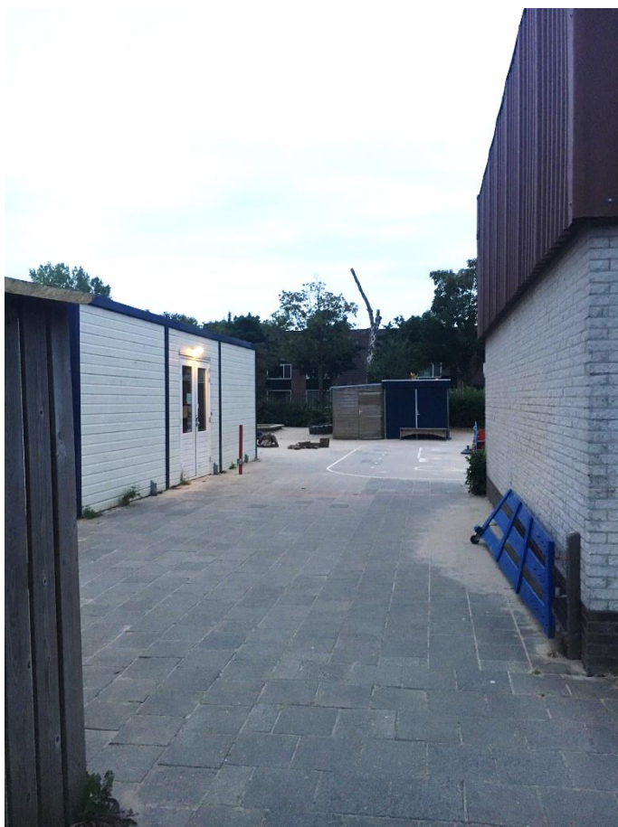
Figuur 13: Bijgebouw met Kinderdagverblijf (links)
