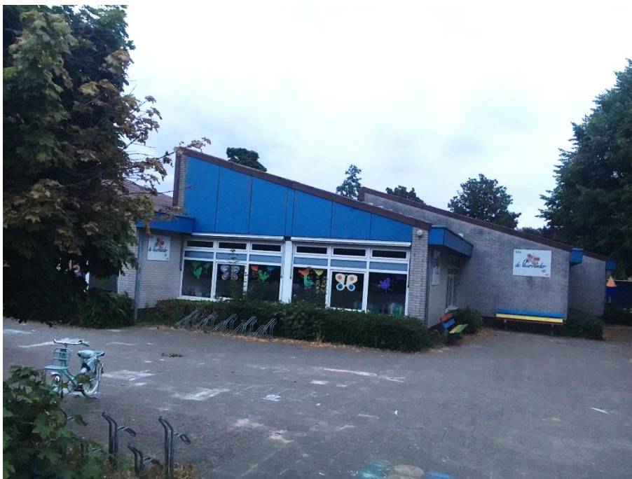
Figuur 11: schoolgebouw ten zuiden van fietspad
