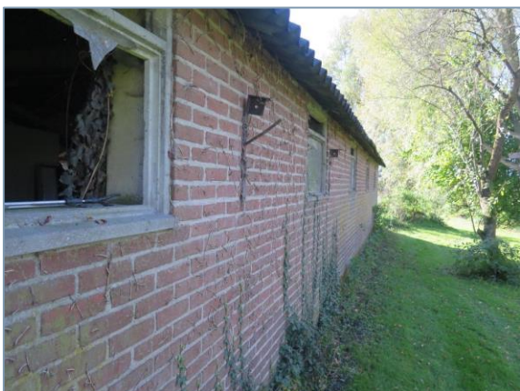
Foto 3. Open raam in oude koeienstal.
