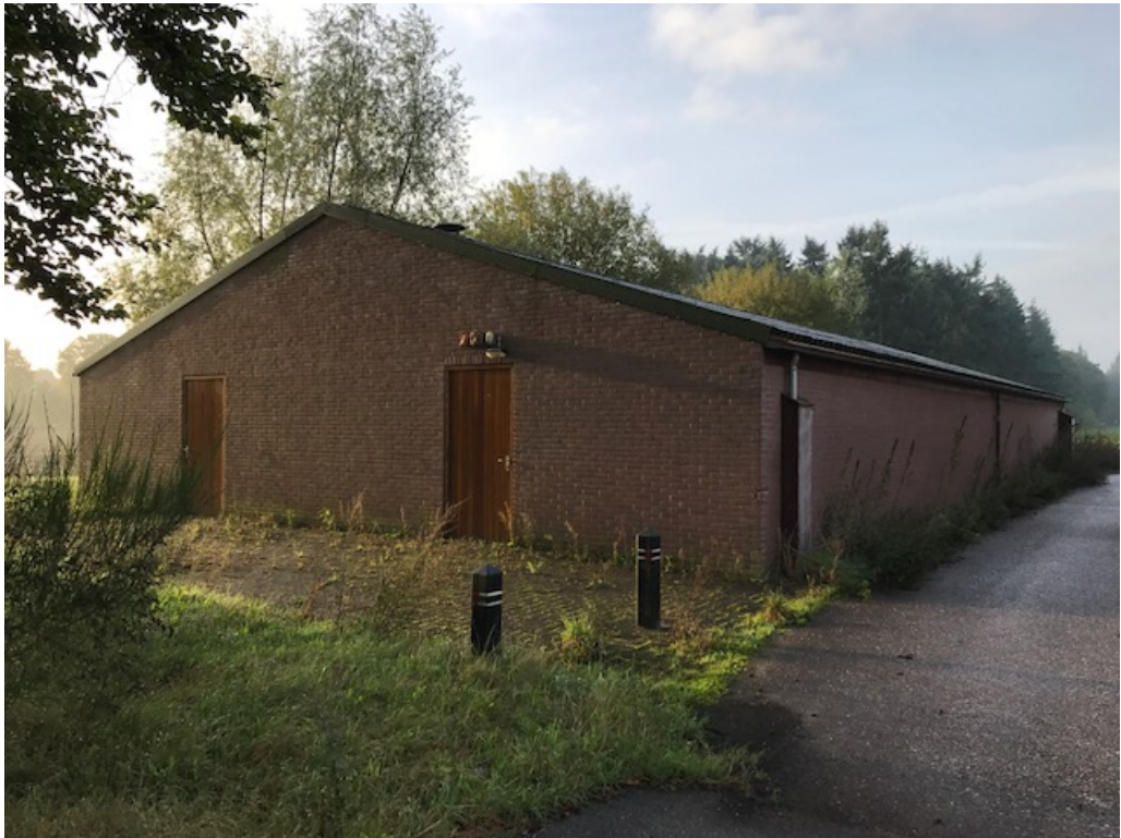
Figuur 3 Op de planlocatie staan 6 voormalige stallen die zijn omgevormd ten behoeve van viskweek (foto boven, stenen schuur, gebouw 7 in figuur 1).
