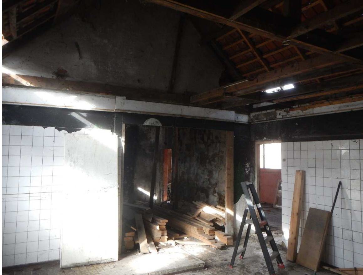
Afbeelding 12. Foto van de noordoostelijke kamer met de doorbraken naar de zuidoostelijke en westelijke kamers.
