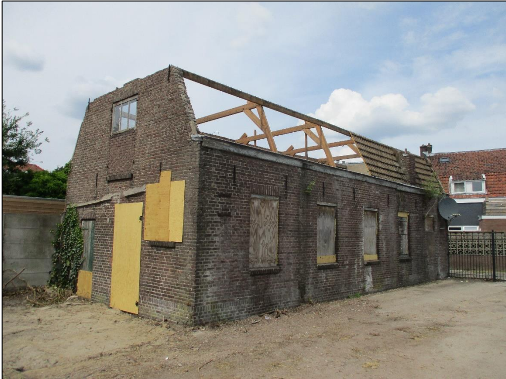
Figuur 3 De kleine schuur, waarbij het dak reeds verwijderd is en slechts de spantconstructie nog aanwezig is.
