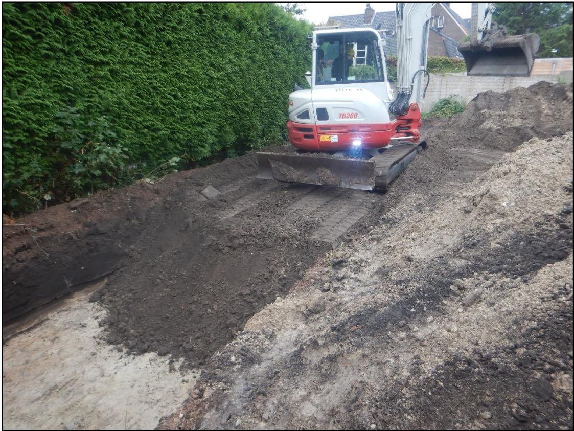
Figuur 8. Aan het einde van de werkzaamheden zijn de proefsleuven weer dichtgedraaid.
