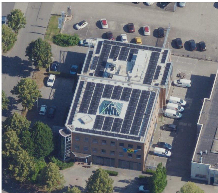
Figuur 4-3: praktijkvoorbeeld koele daken i.c.m. zonnepanelen
