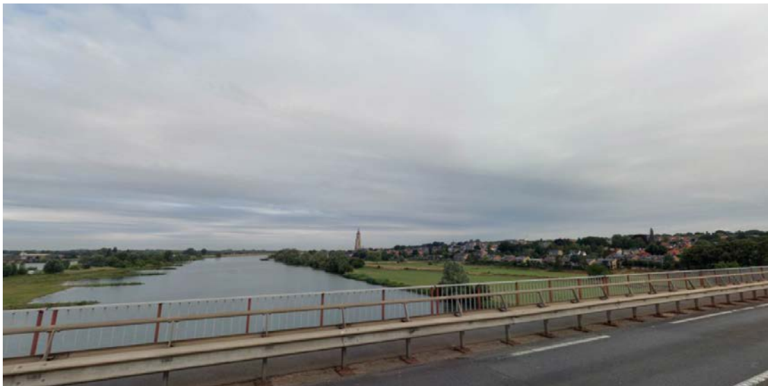
Figuur 7.3 Open en grootschalig landschap vanaf de Rijnbrug met op de achtergrond de Cuneratoren (bron: https://streetsmart.cyclomedia.com/streetsmart )
