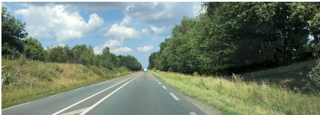
Figuur 1 Bossages op de geluidwallen aansluitend op de heuvelrug ten zuiden van deelgebied 1
