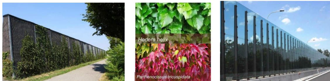
Figuur 8 voorbeeld van klimbeplanting tegen een geluidsscherm, soorten beplanting en een transparant geluidsscherm
