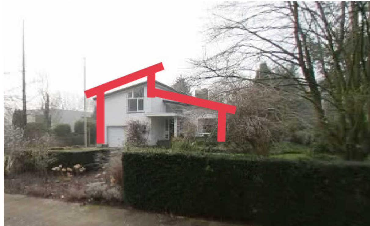
Bovenstaande foto toont een woning opgebouwd uit twee volumes, beide met een lessenaarsdak. In Balkon-Zuid zijn geen witte / lichte stenen toegestaan.
