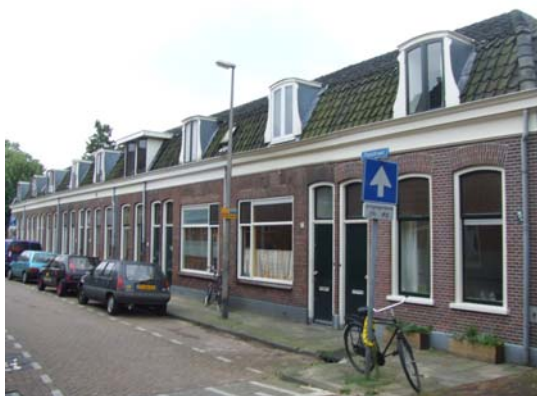
Gave gevelwand aan de Zonstraat
