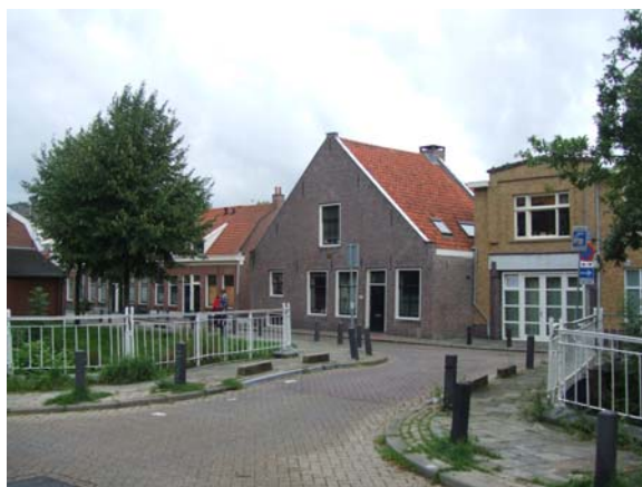
Monumentale boerderij aan de Zonstraat
