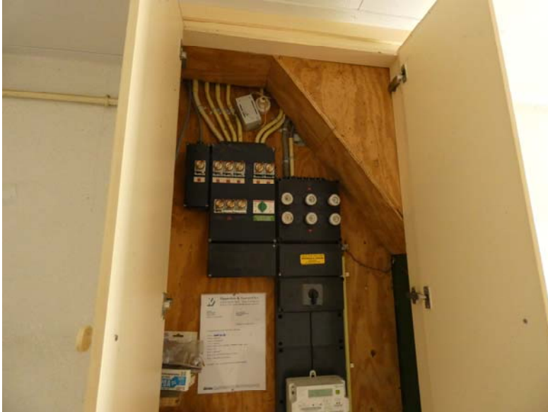
De meterkast met rechts de afgetimmerde gebintstijl en korbeel.
