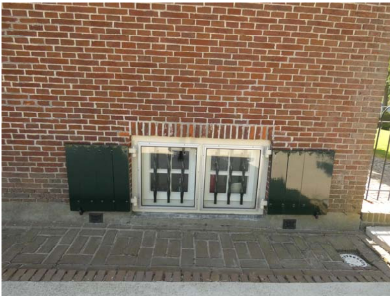
Het dubbele keldervenster in de linker zijgevel. Het keldervenster is voorzien van gedraaide dief-ijsers en buitenluiken. De voorzetramen zijn niet authentiek.
