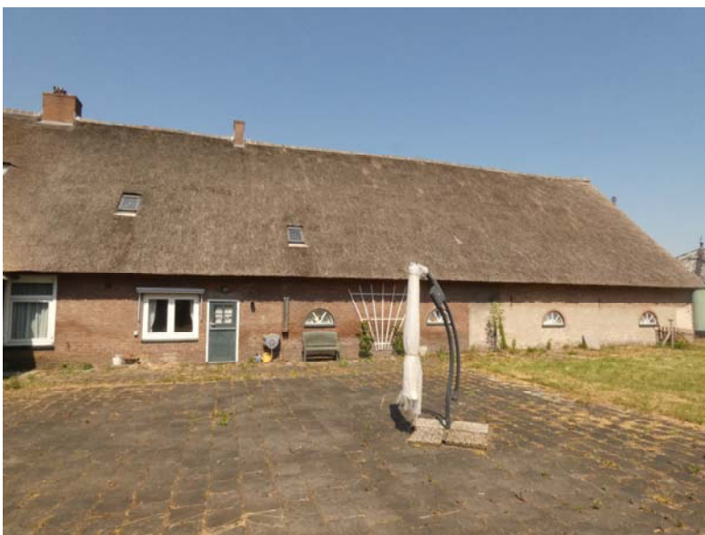
Het stalgedeelte met vier halfronde stalvensters van gietijzer. De eerste twee vensters van het oudere deel zijn anders dan de vensters in het nieuwere (gepleisterde) deel.
