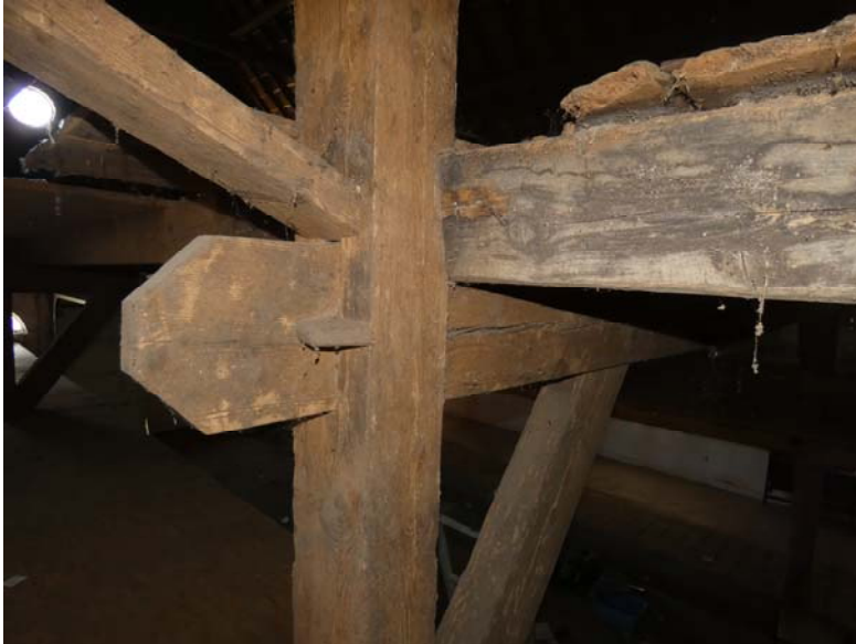
Ankerbalk met een boekige pen bij het achterste en nieuwere aangebouwde staldeel.
