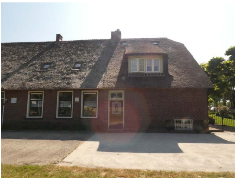
Het woongedeelte, dat tegenwoordig in tweeën is gesplitst. De scheiding tussen nr. 514 (voor) en 516 (achter) ligt bij de brandmuur, te herkennen aan de rechter schoorsteen.
