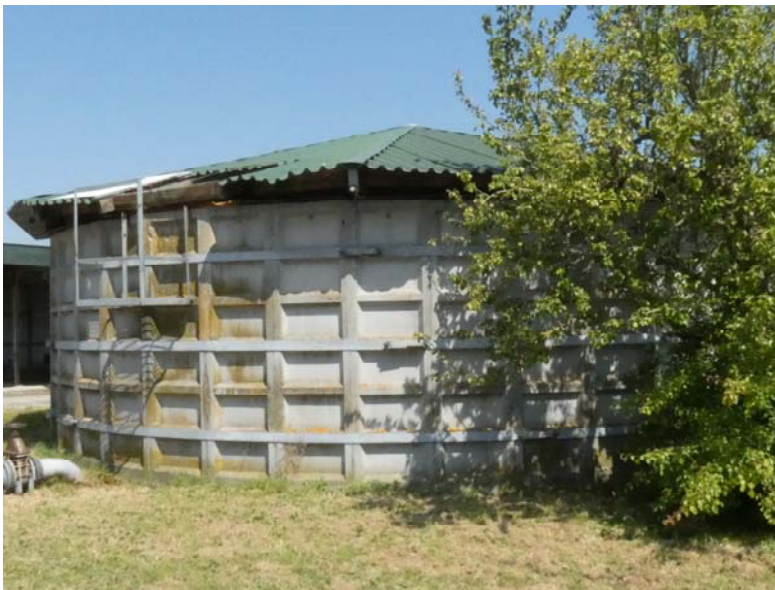
Betonnen silo voor mestopslag met golfplaten dak op het achtererf.
