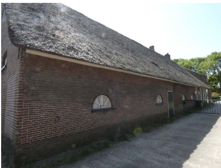
De linker zijgevel gezien vanaf de achtergevel.
