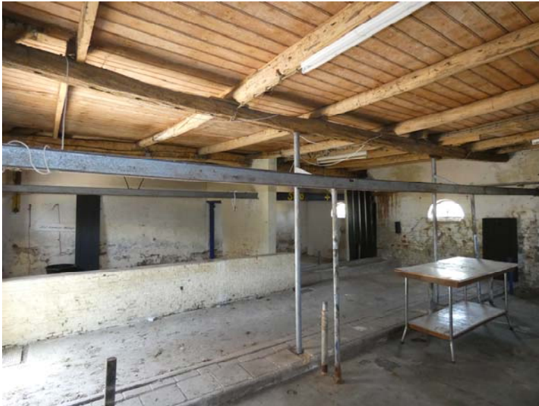
Het stalgedeelte van het bijgebouw. In de vloer zijn voergeulen te zien en het lage muurtje is een restant van het varkensverblijf.
