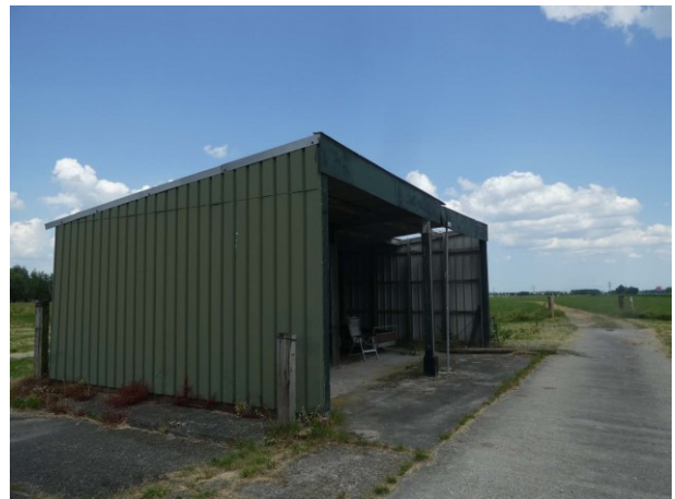
Figuur 7 Overzicht metalen overkapping
