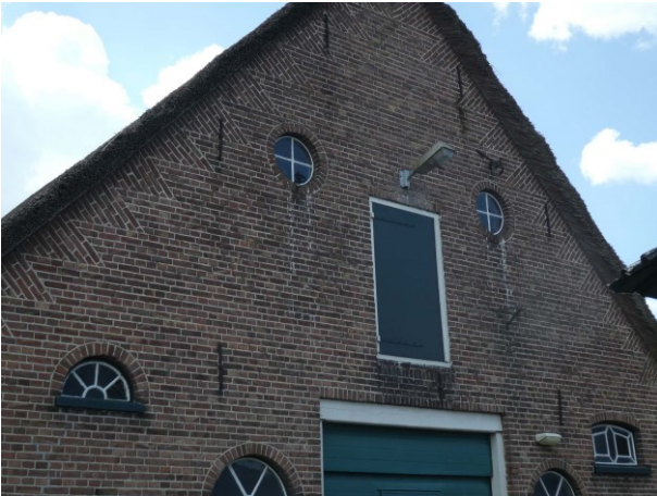
Figuur 19 Achtergevel zonder open stootvoegen
