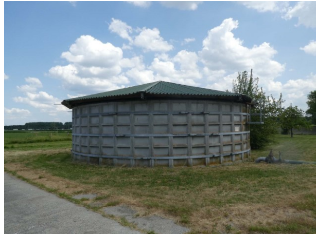
Figuur 25 Overzicht betonnen silo met damwandplaten dak
