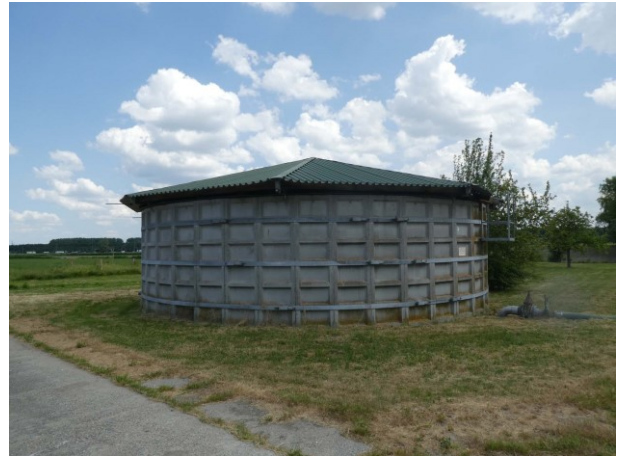
Figuur 5 Overzicht mestsilo
