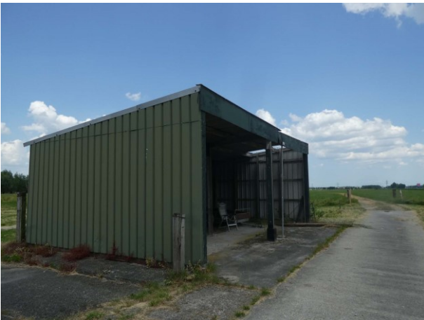
Figuur 23 Overzicht metalen overkapping
