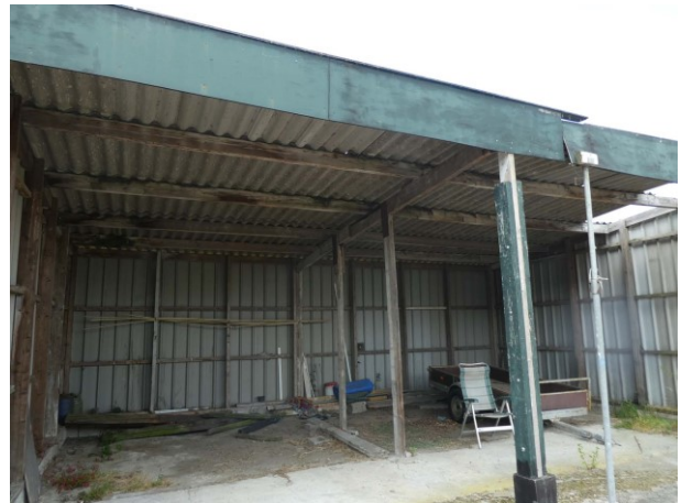
Figuur 24 Overzicht binnenzijde overkapping
