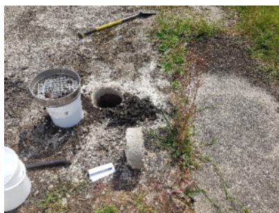
Afbeelding 7: kernboring door beton
